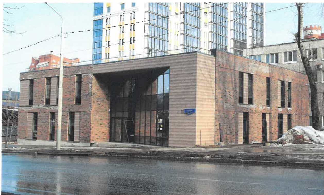
Главный фасад со стороны ул. Пушкина
