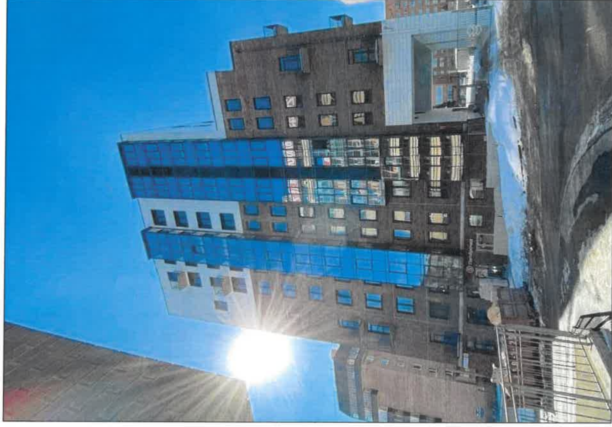
Главный фасад по ул. Решетникова
