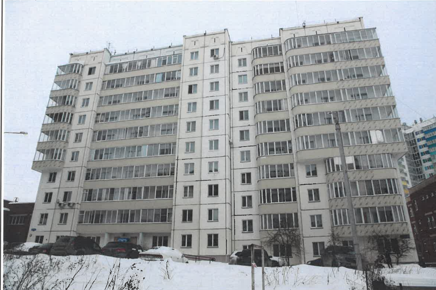
Главный фасад в осях 1-3
