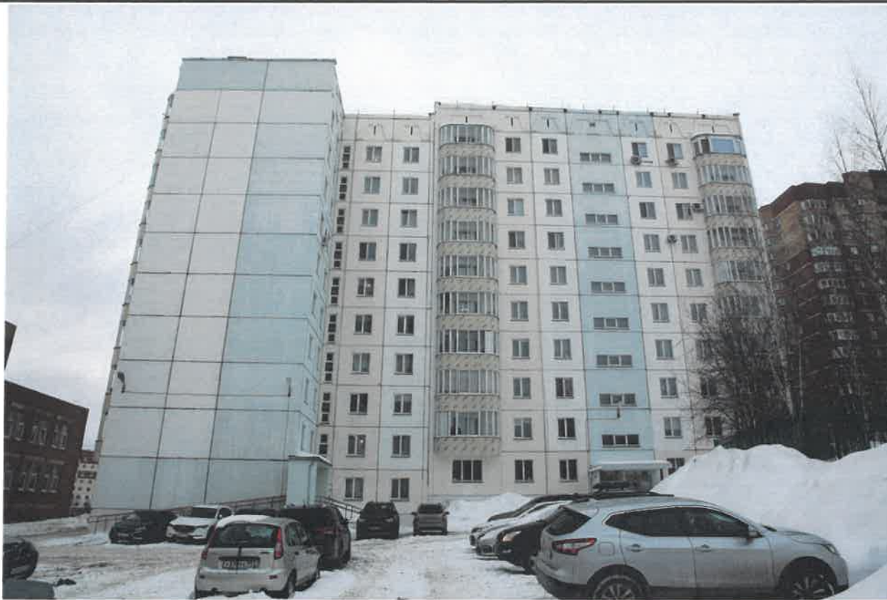
Дворовой фасад в осях 3-1
