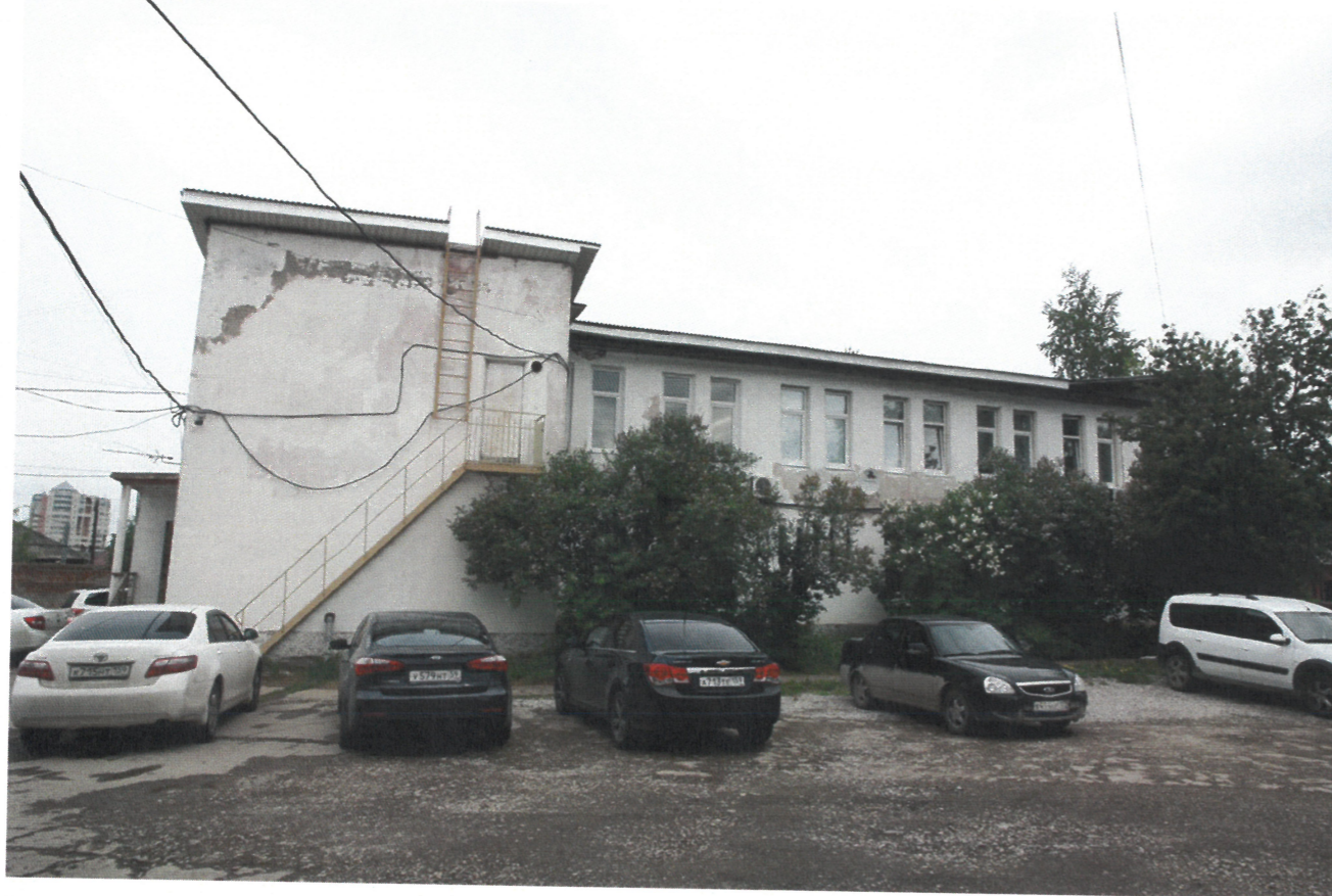
Дворовой фасад в осях 3-1
