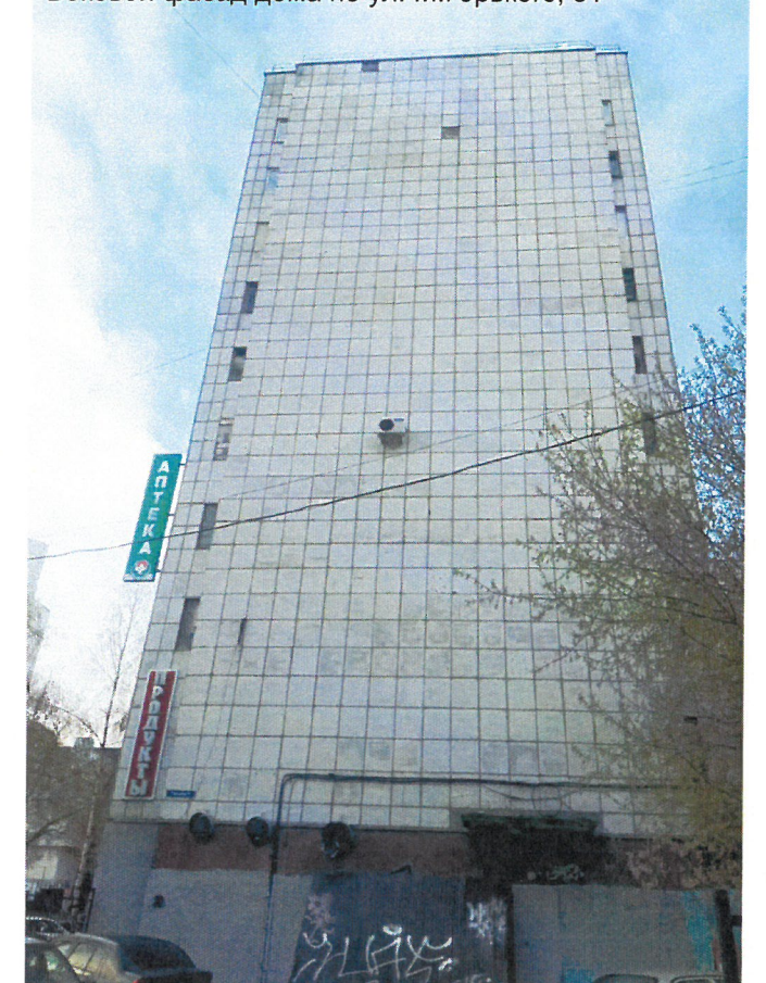
Боковой фасад дома по ул. М.Горького, 51
