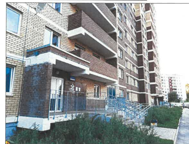
Фрагмент главного фасада
