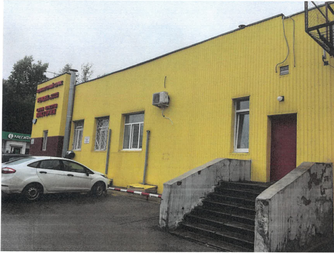
Фрагмент бокового фасада по ул. Хабаровской
