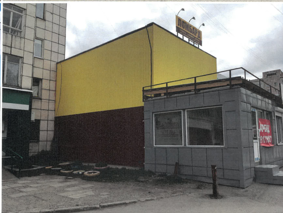
Фрагмент бокового фасада
