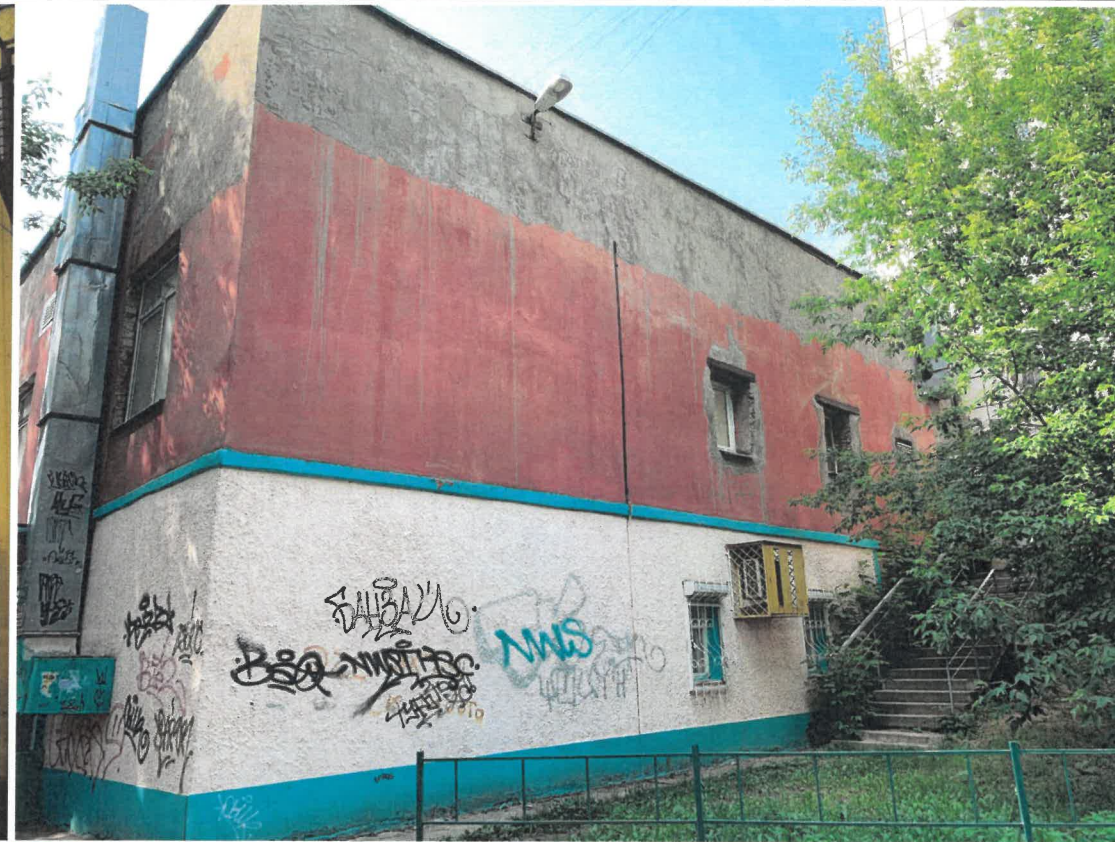
Фрагмент бокового фасада
