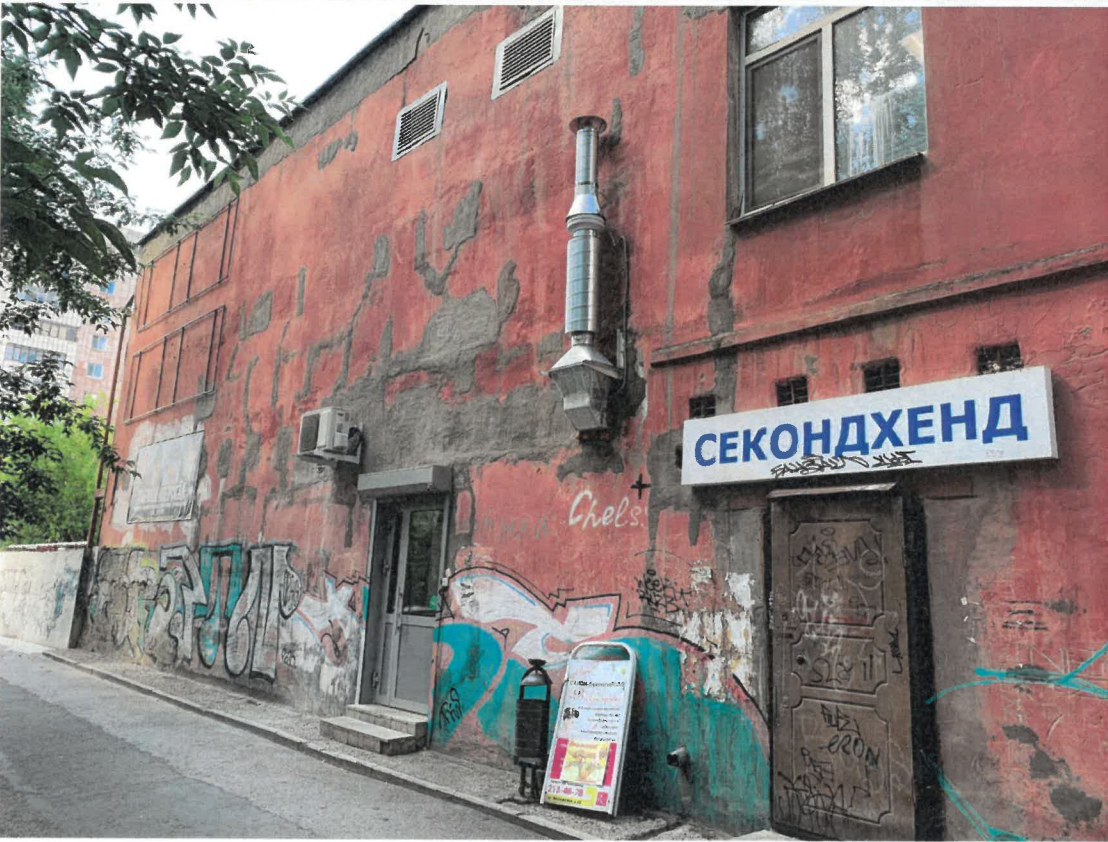
Фрагмент дворового фасада
