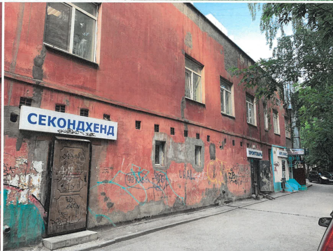
Фрагмент дворового фасада
