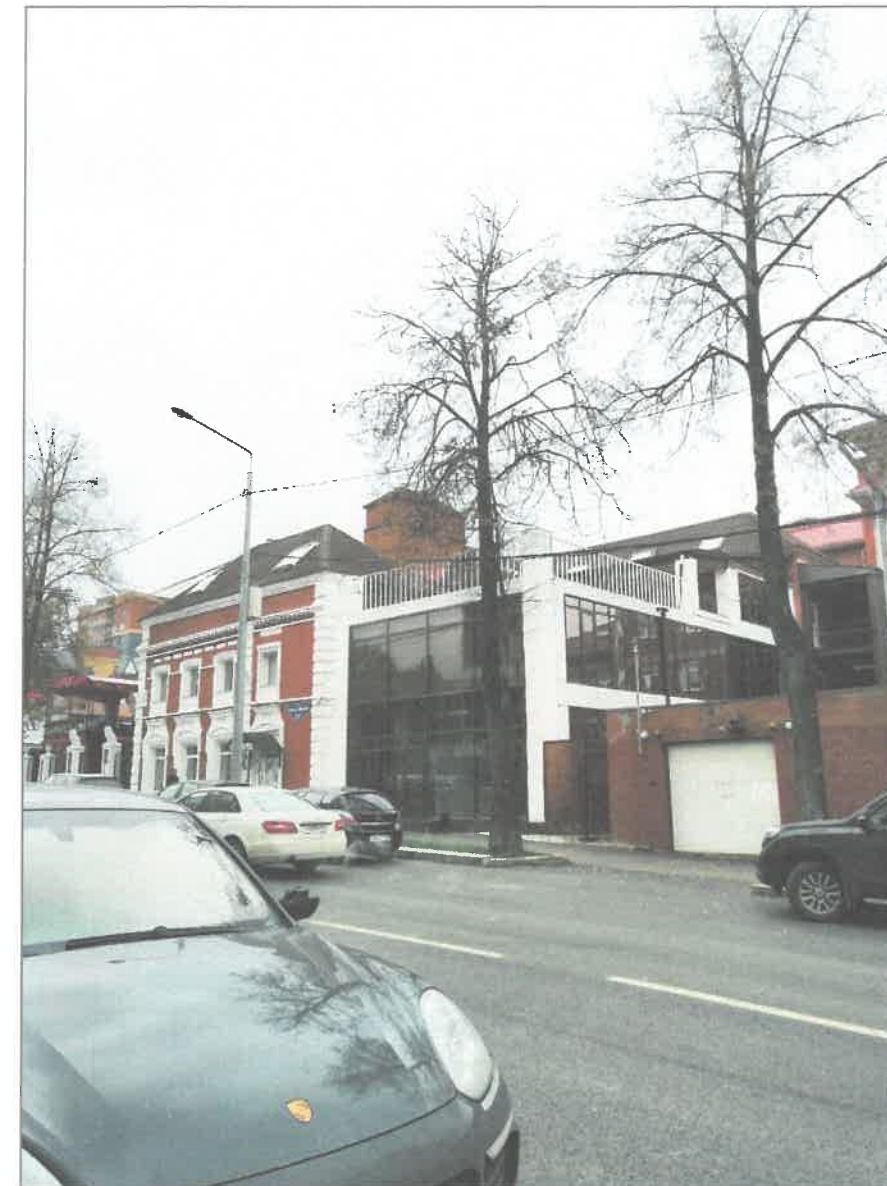
Главный фасад по ул.Газеты Звезда
