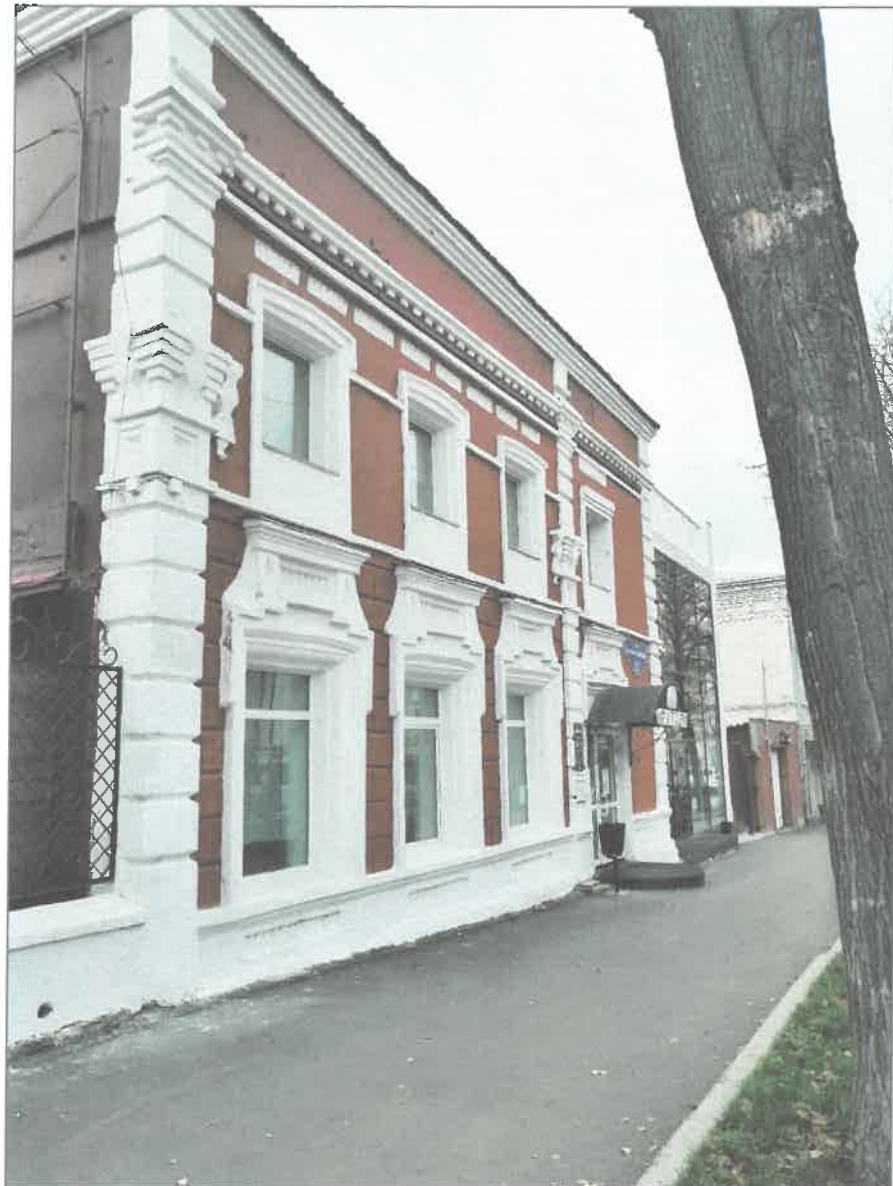
Главный фасад по ул.Газеты Звезда
