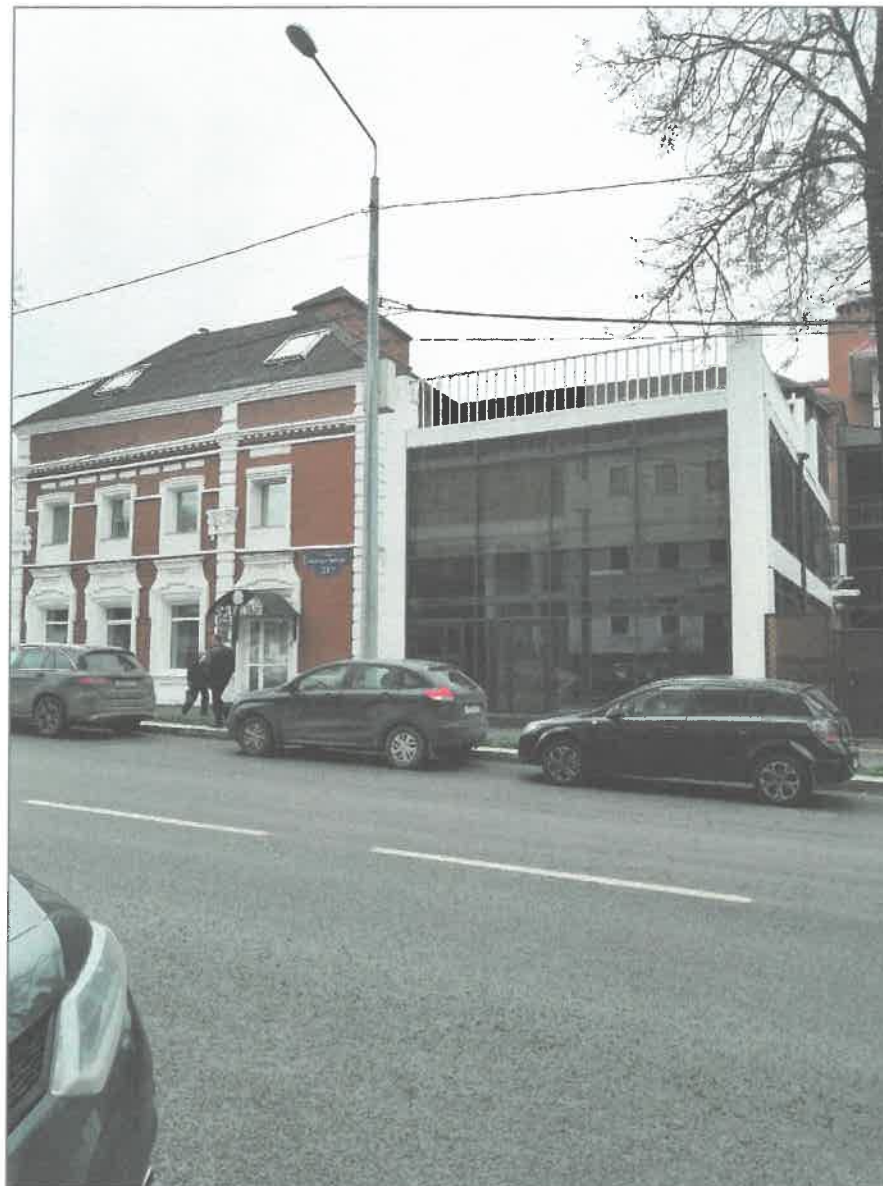
Главный фасад по ул.Газеты Звезда
