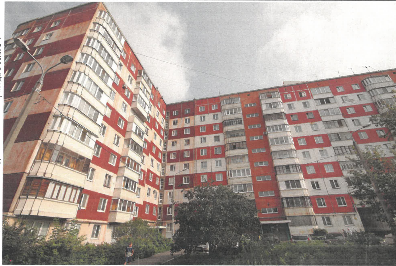
Главный фасад в осях А-В и фрагмент главного фасада в осях 3-4
