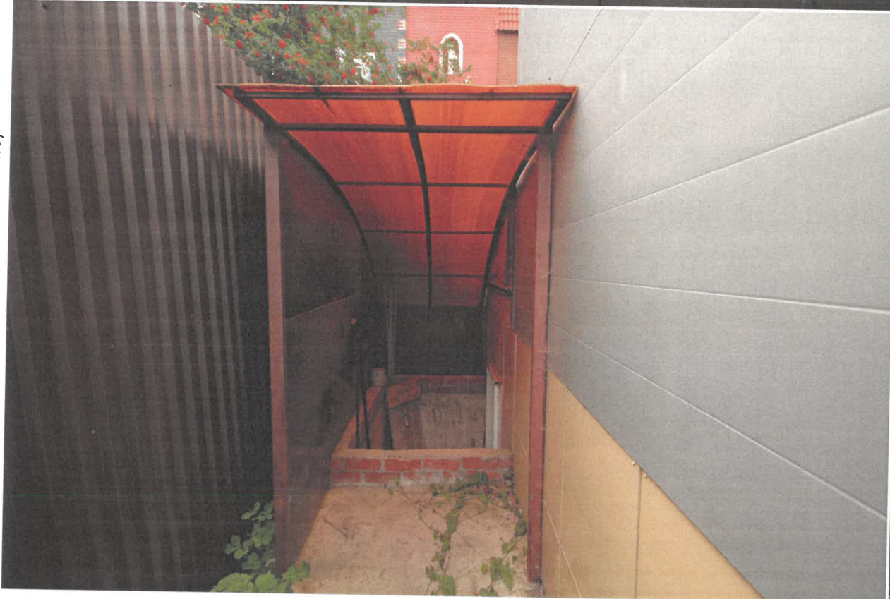
Фрагмент бокового фасада (левого относительно главного)
