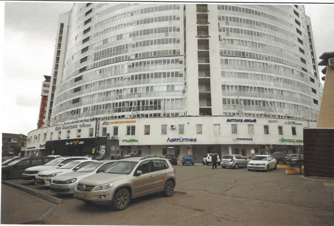
Фрагмент главного фасада со стороны пересечения ул. Мира и ул. Советской Армии
