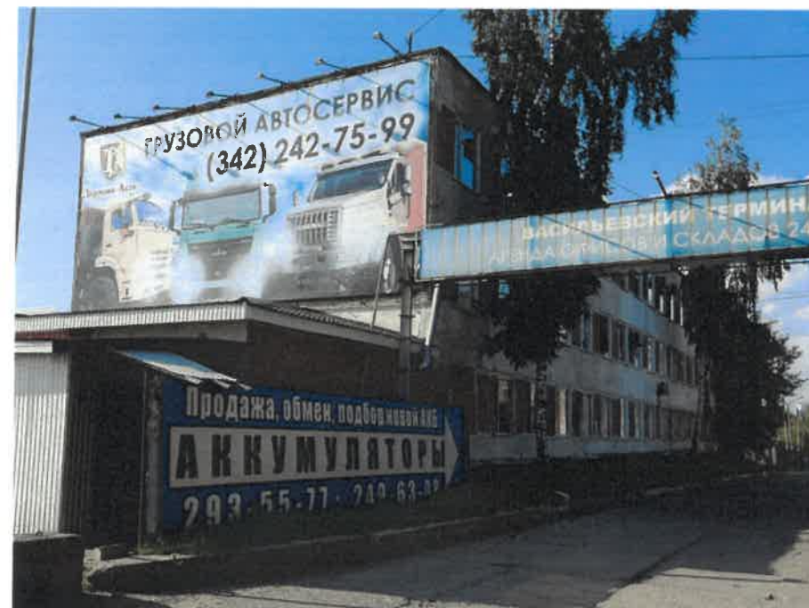
Боковой фасад / Дворовый фасад
