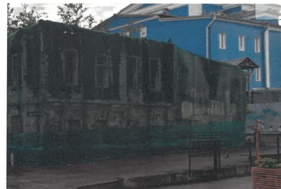
Существующее состояние бокового фасада
