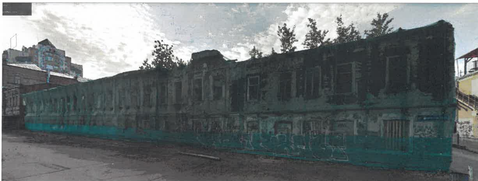
Существующее состояние главного фасада
