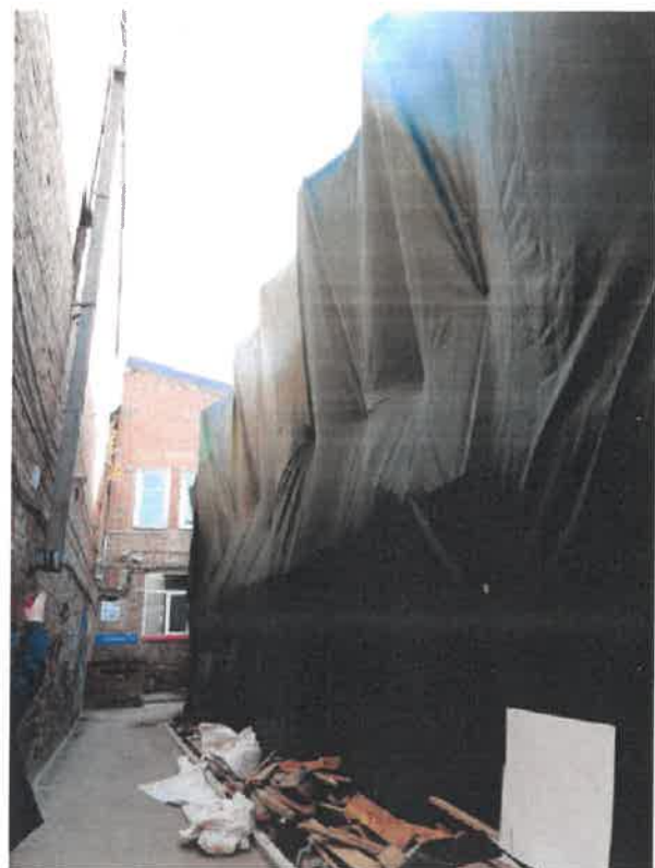
Существующее состояние бокового фасада
