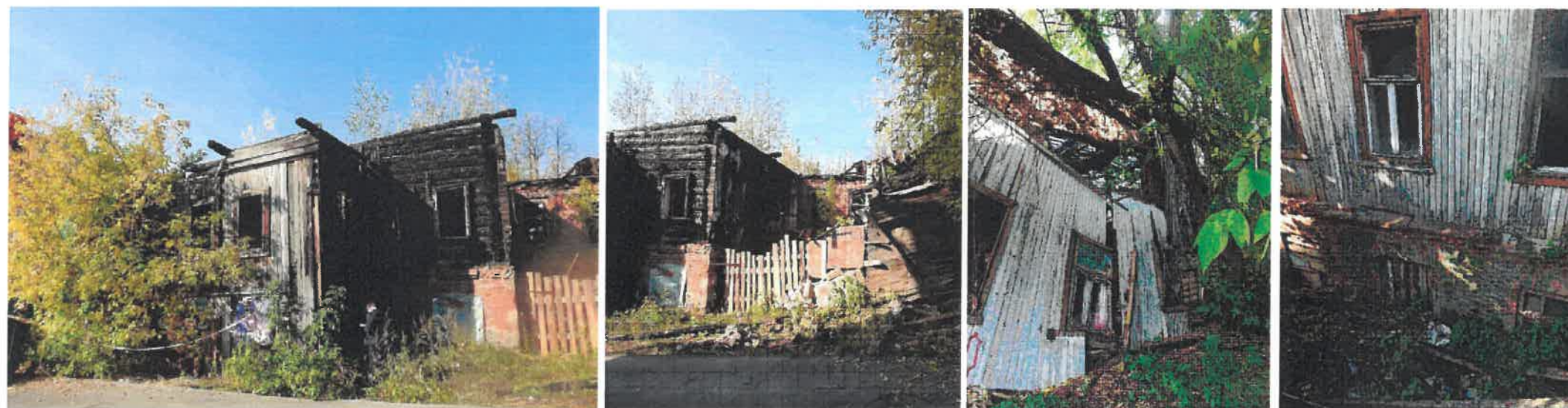
Существующее состояние дворового фасада
