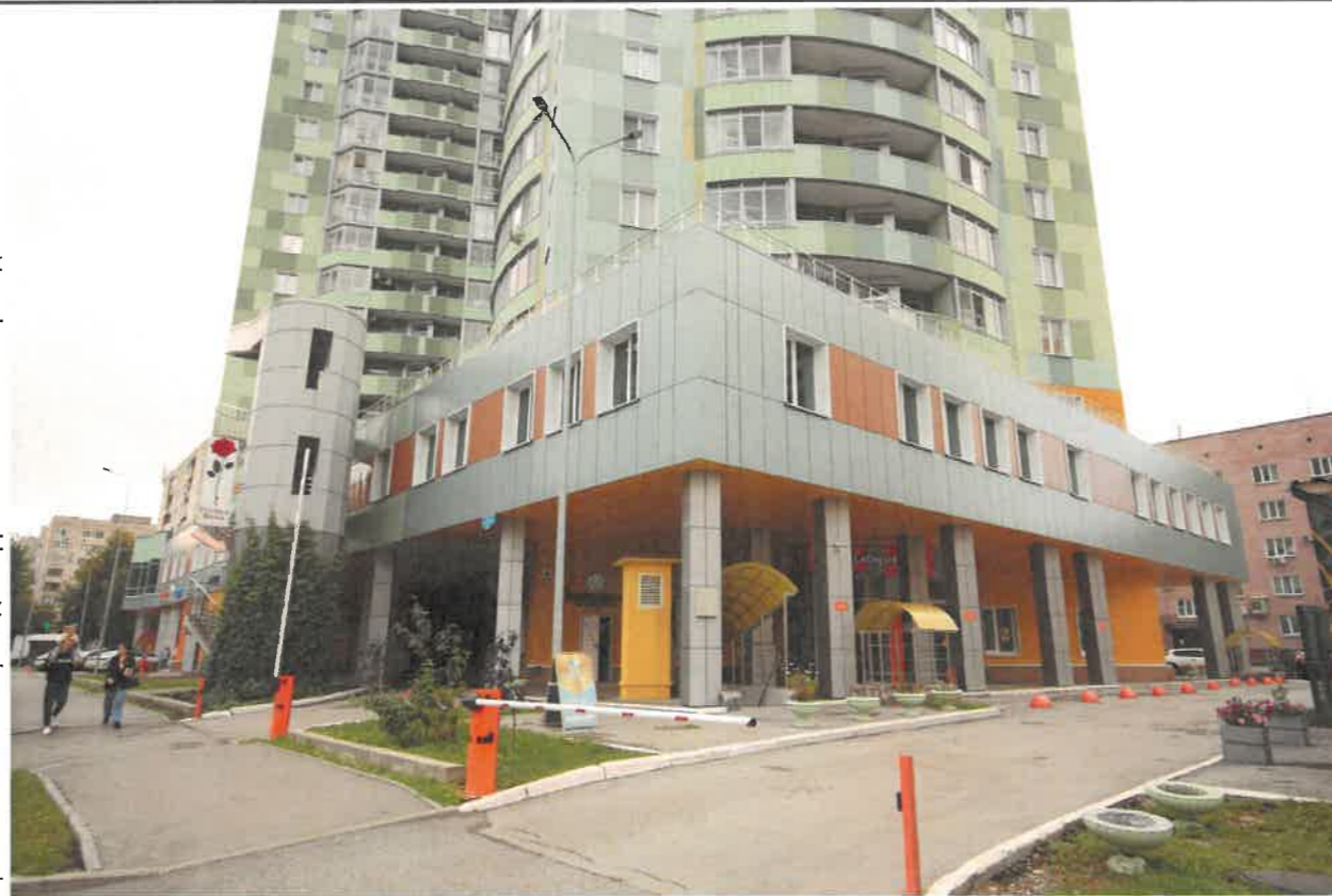
Фрагмент главного фасада и фрагмент бокового фасада в осях Г-3
