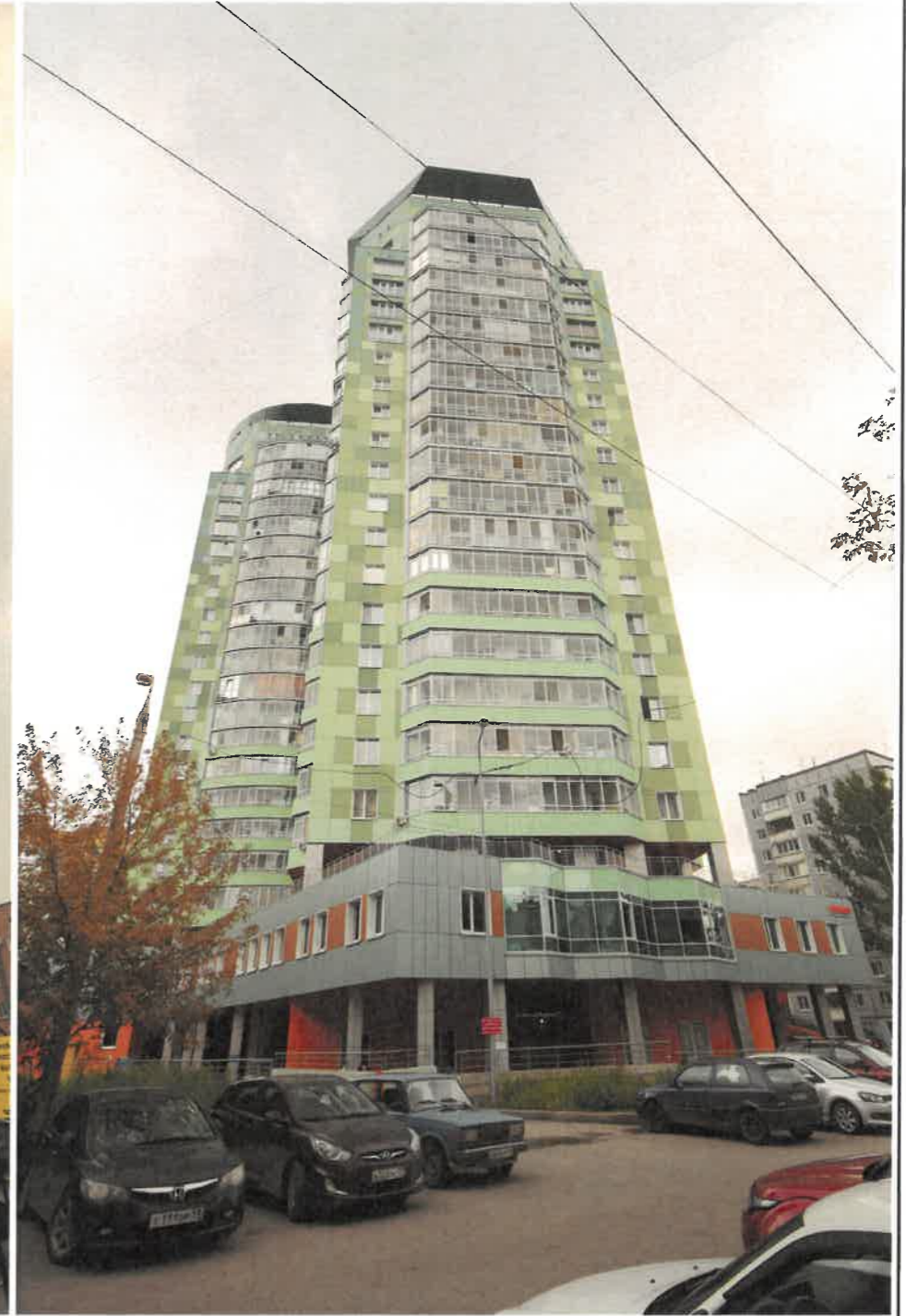
Фрагмент дворового фасада и боковой фасад в осях Д-А
