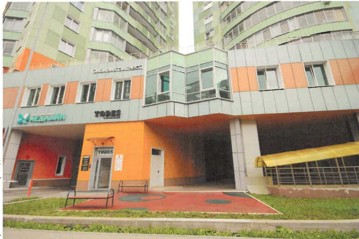
Фрагмент главного фасада
