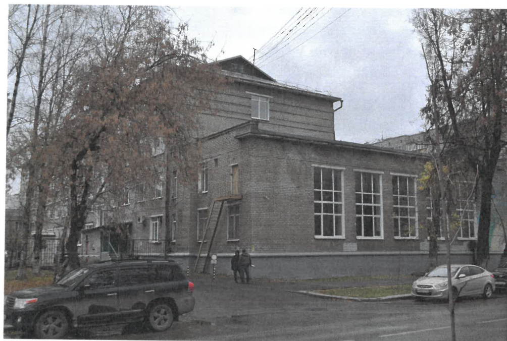
Фото 7. Вид со стороны двора по ул. 25 Октября
