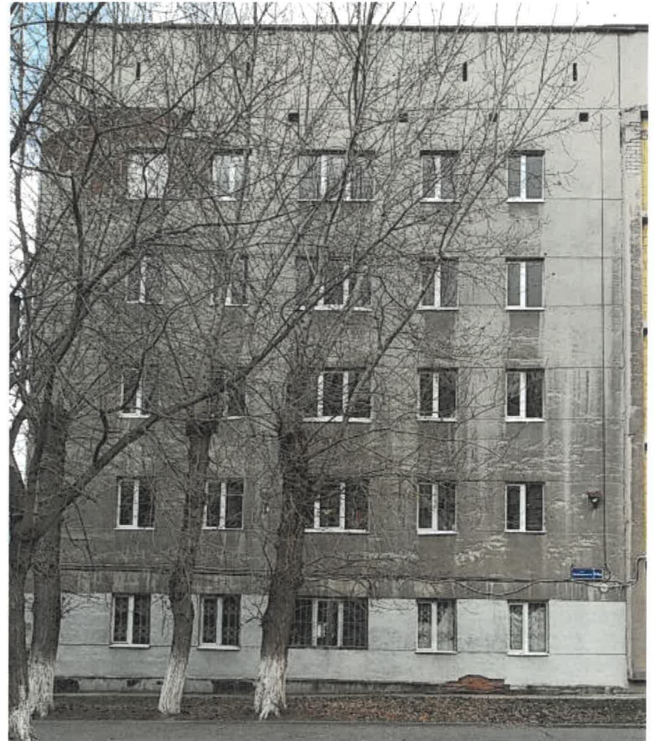
Существующее состояние бокового фасада (фотофиксация).
