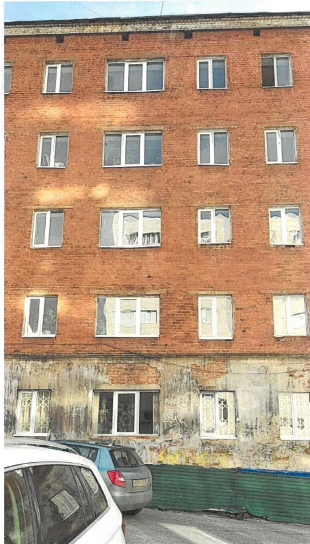
Существующее состояние бокового фасада (фотофиксация).
