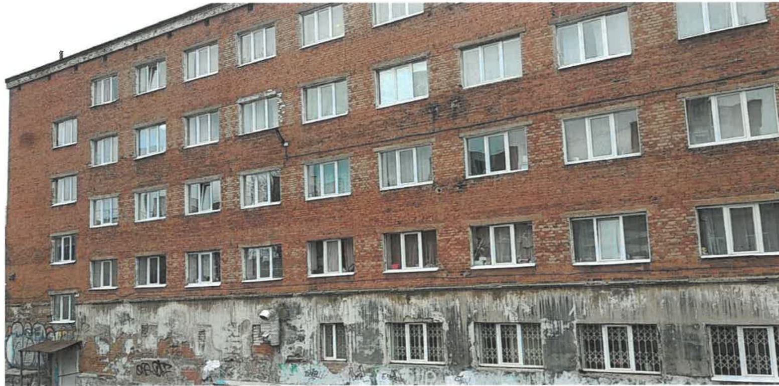
Существующее состояние главного фасада (фотофиксация).
