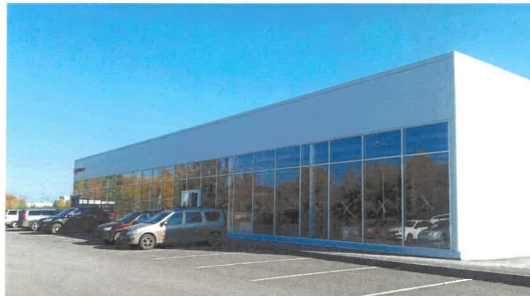
Главный фасад по ул.Ново-Гайвинская
