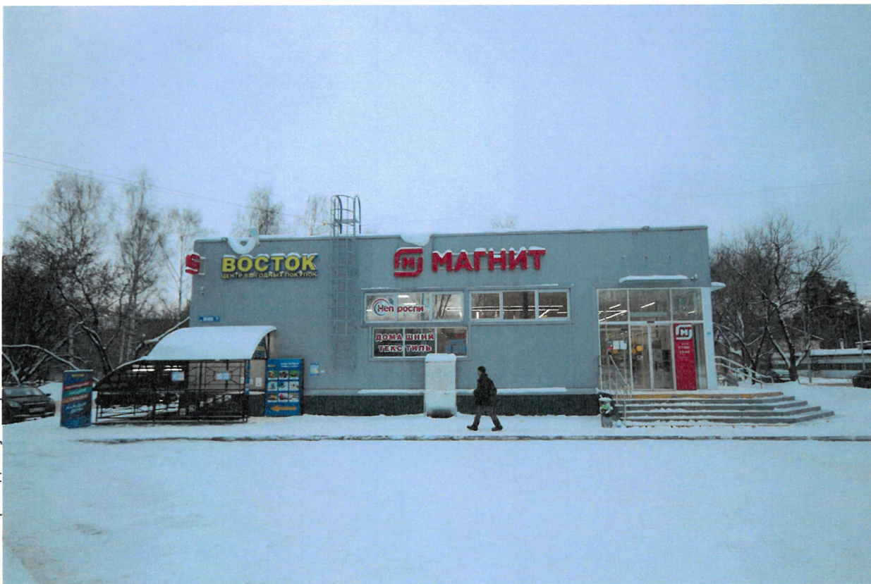
Боковой фасад по ул. Торговая
