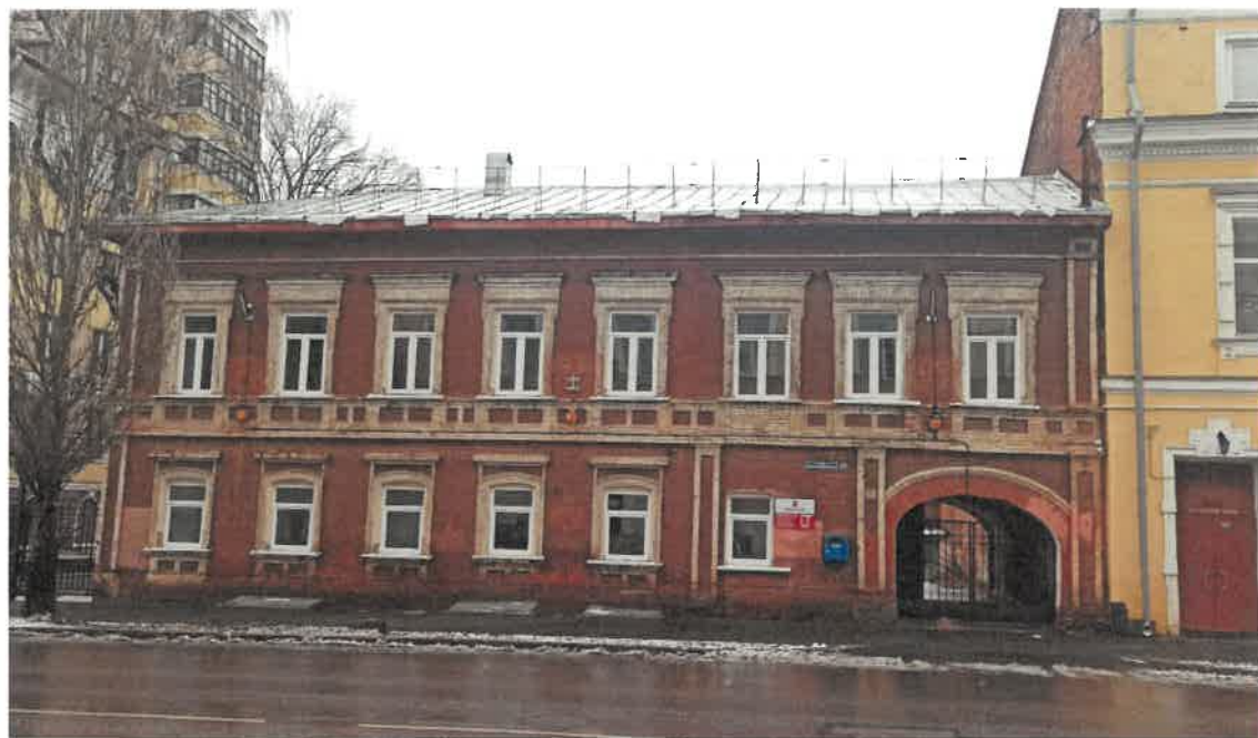
Существующее состояние главного фасада (фотофиксация).
