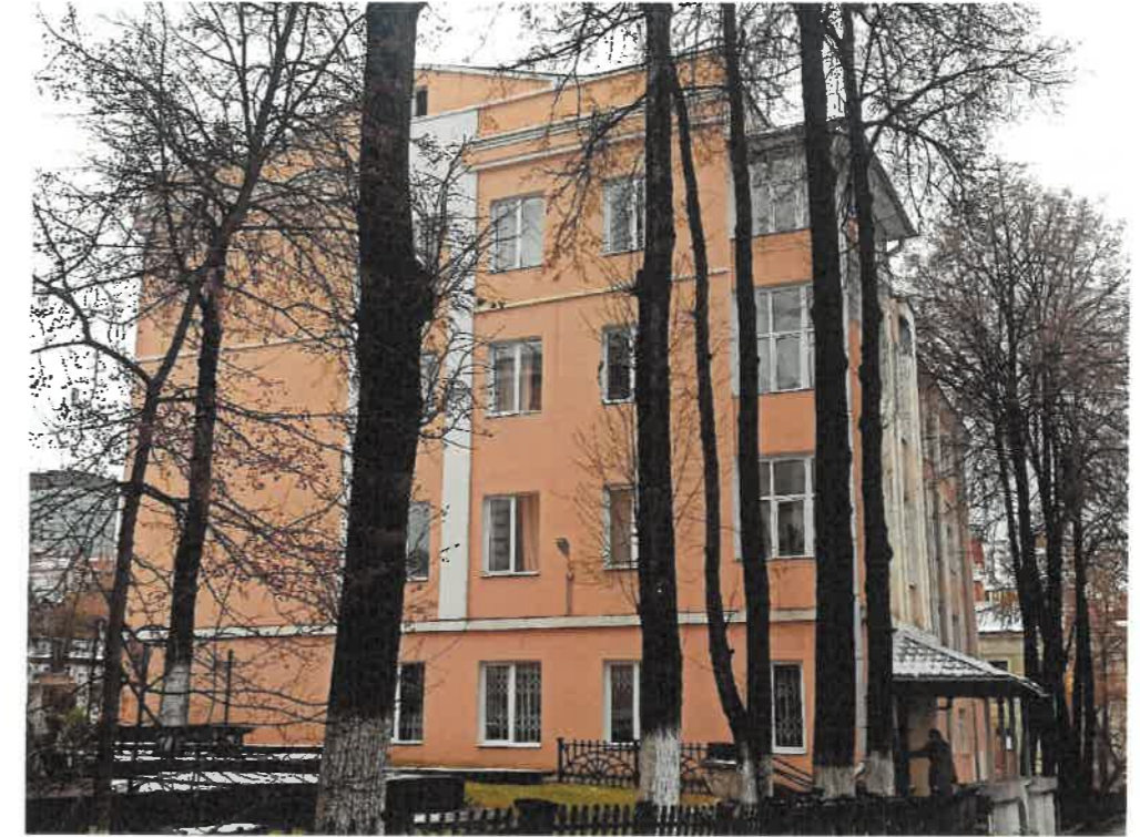
Существующее состояние бокового фасада (фотофиксация).
