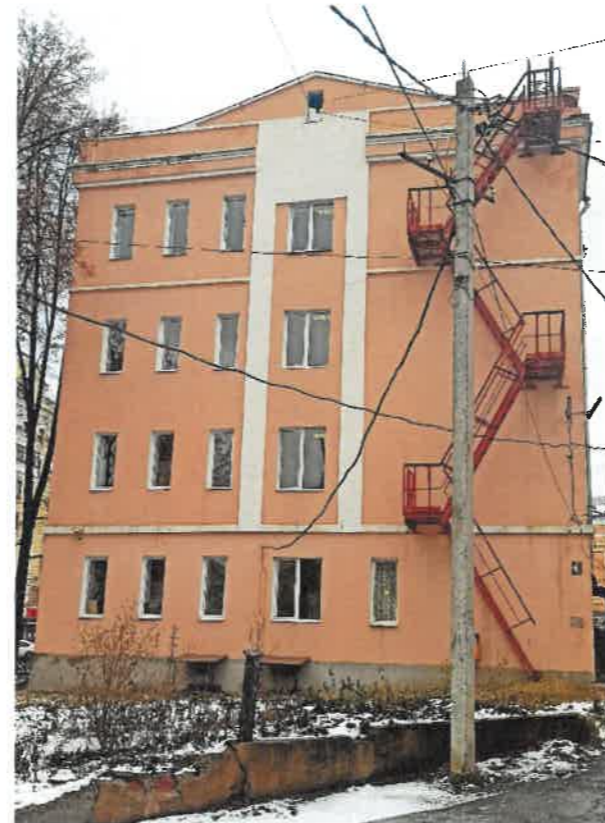
Существующее состояние бокового фасада (фотофиксация).
