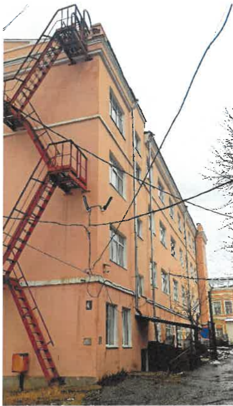
Существующее состояние дворового фасада (фотофиксация)
