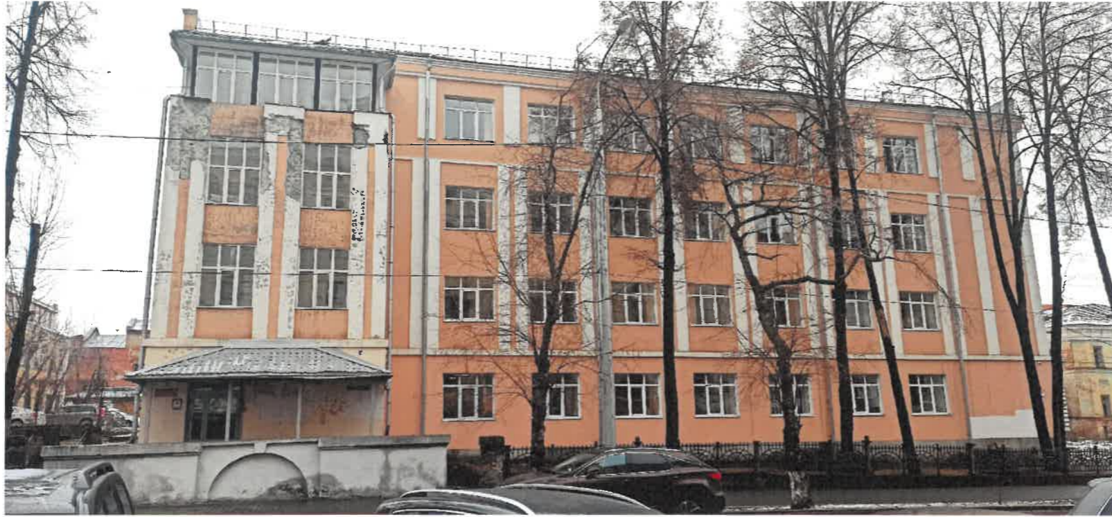
Существующее состояние главного фасада (фотофиксация).
