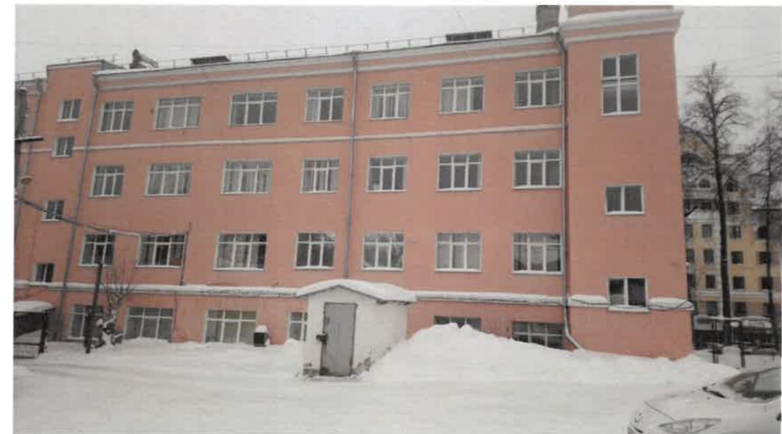
Существующее состояние дворового фасада (фотофиксация)
