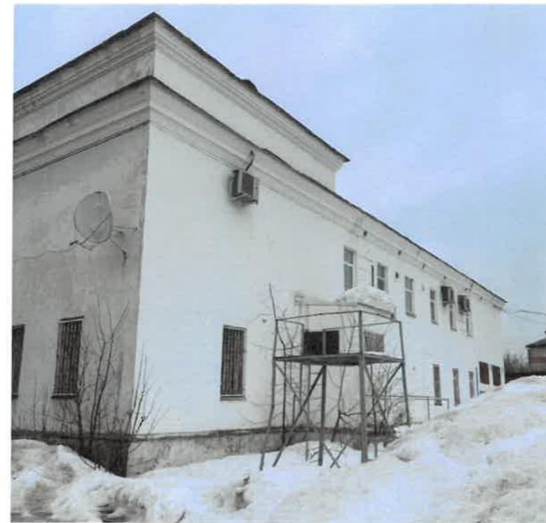
Существующее состояние дворового фасада (фотофиксация)
