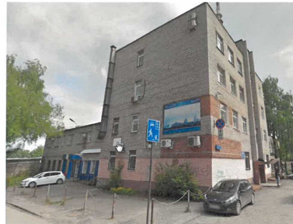
Существующее состояние бокового фасада (фотофиксация).
