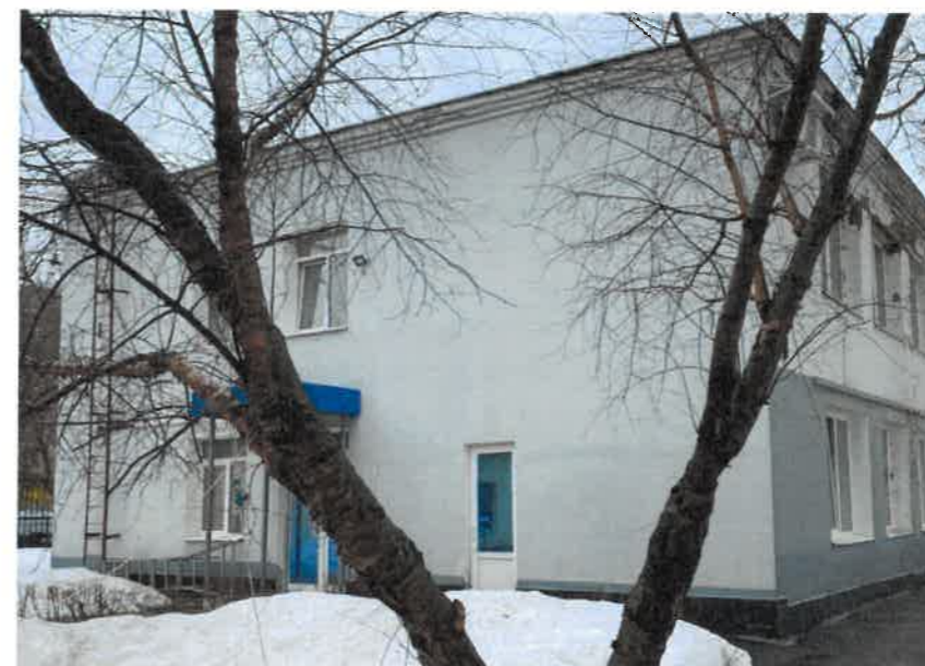
Существующее состояние бокового фасада (фотофиксация).
