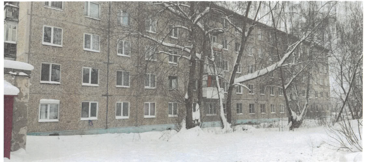
Фасад в осях 2-3 (существующее положение)
