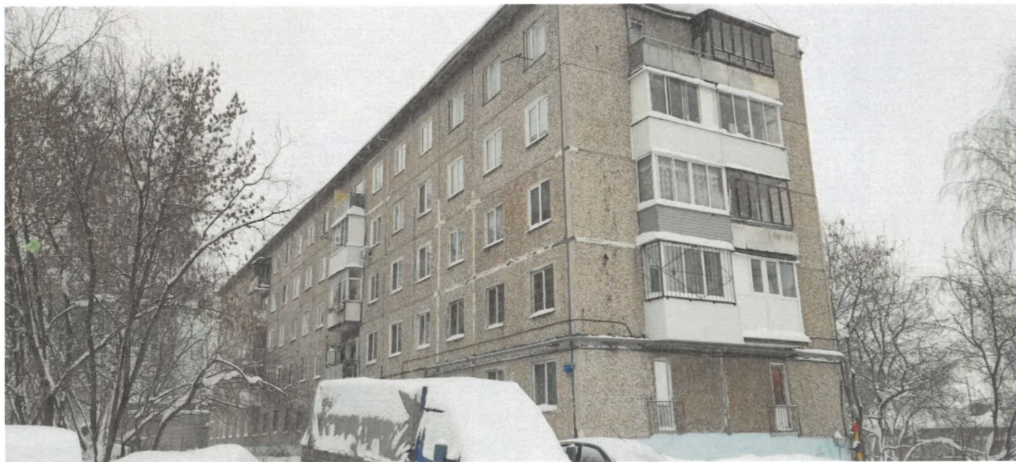
Фасад в осях 2-3 (существующее положение)
