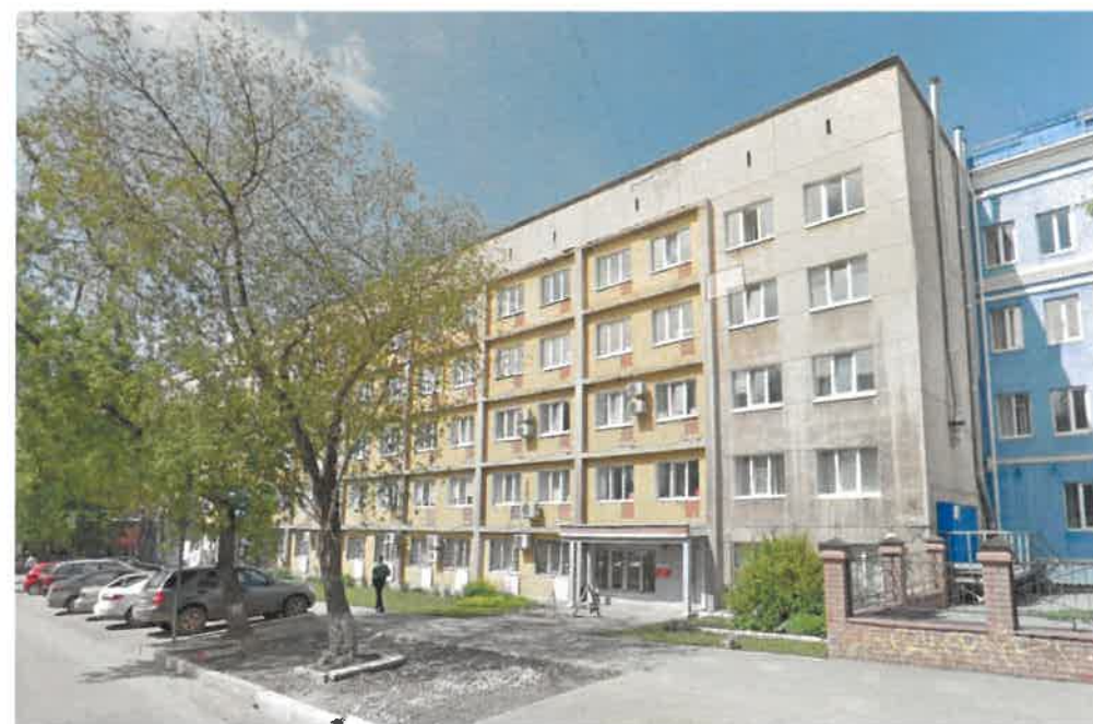
Существующее состояние бокового фасада (фотофиксация).
