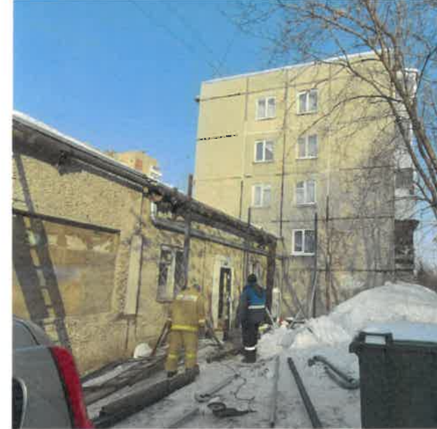
Боковой фасад МКД и дворовой пристроенной части
