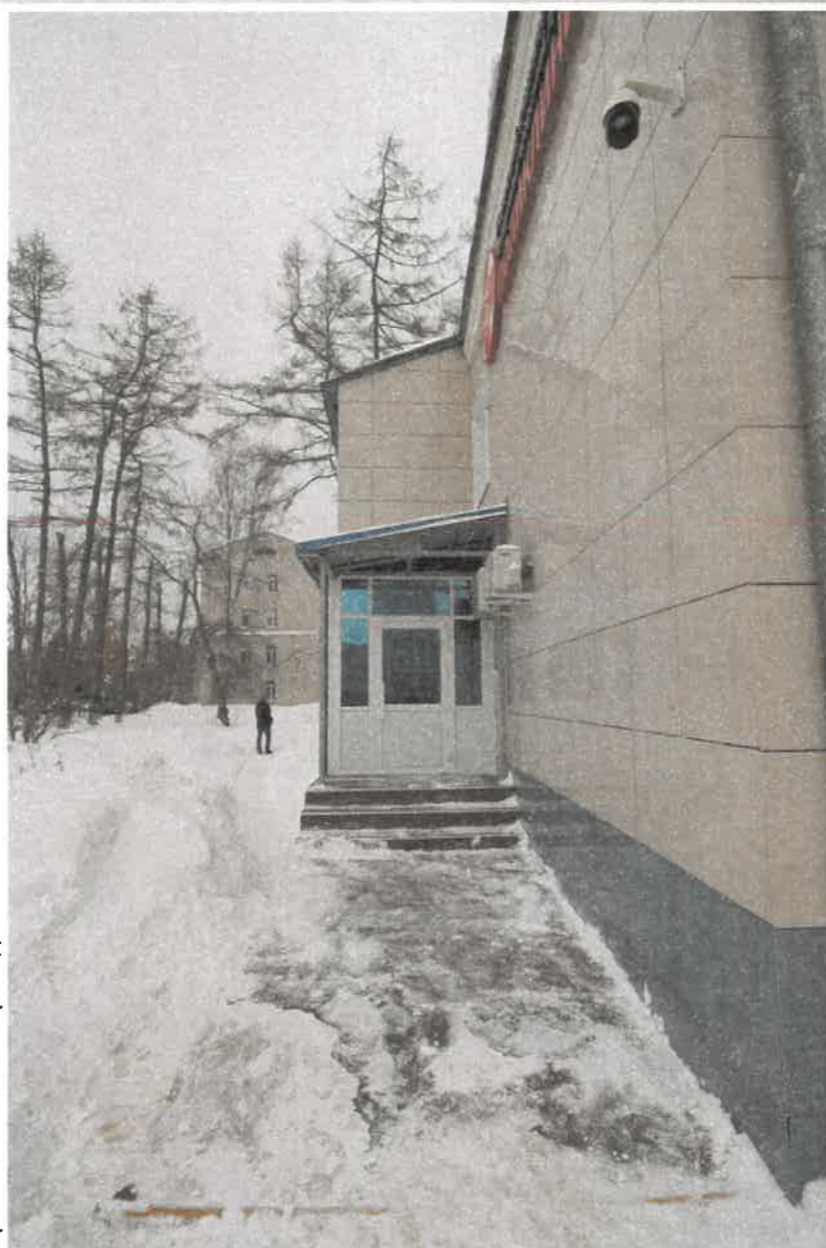
фрагмент главного фасада
