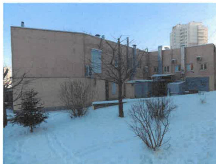
Дворовой фасад/Боковой фасад
