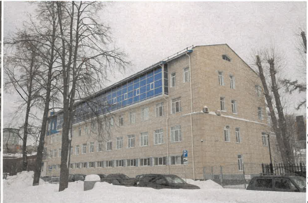
Главный фасад по ул. Сибирской и боковой фасад
