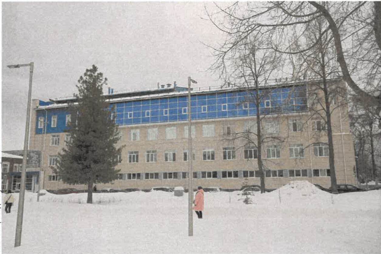
Главный фасад по ул. Сибирской
