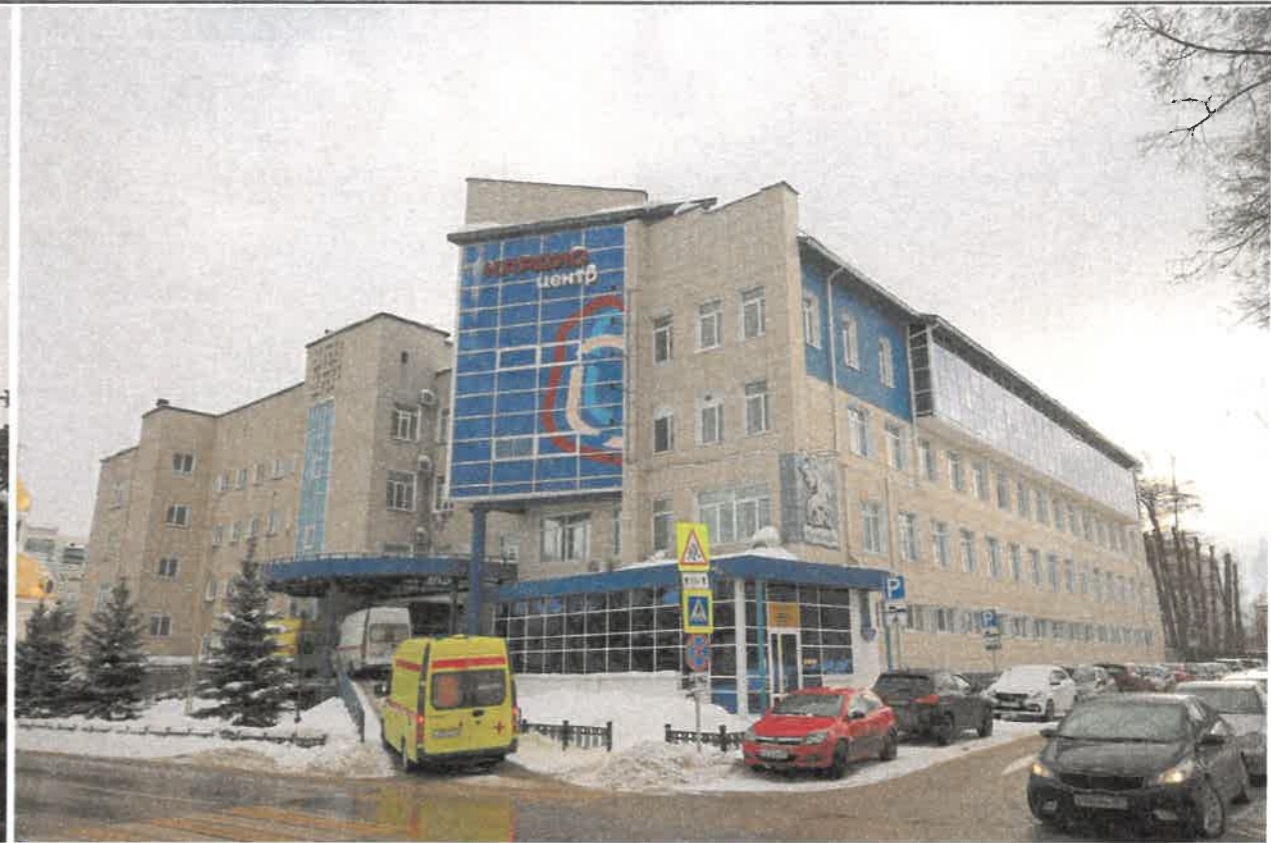
Главные фасады по ул. Полины Осипенко и ул. Сибирской
