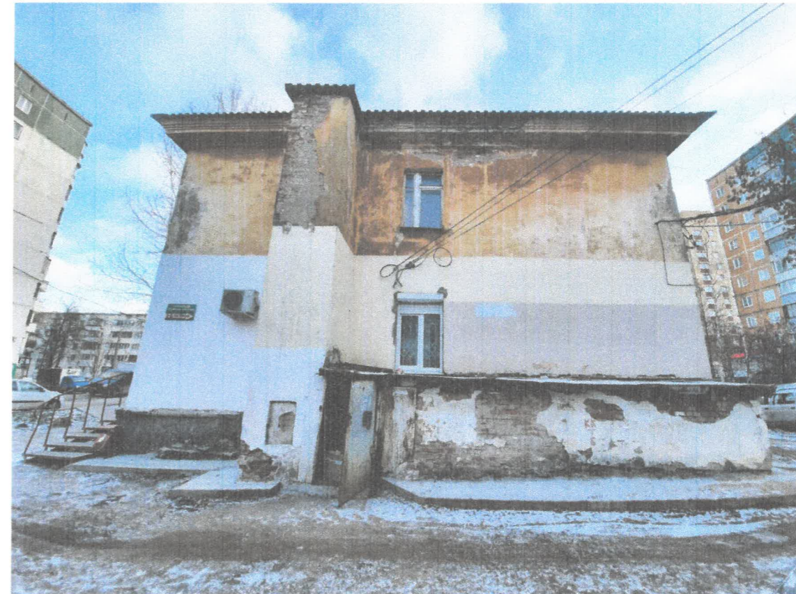
Существующее состояние бокового фасада
