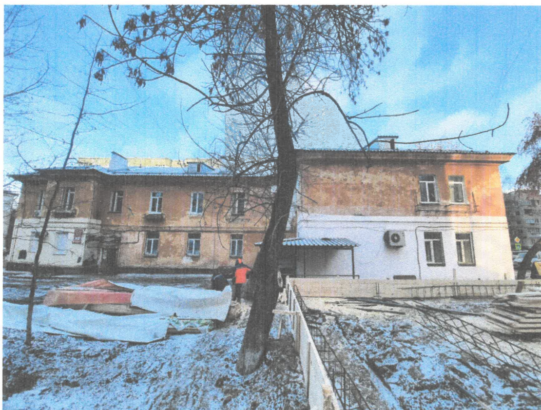
Существующее состояние дворового фасада
