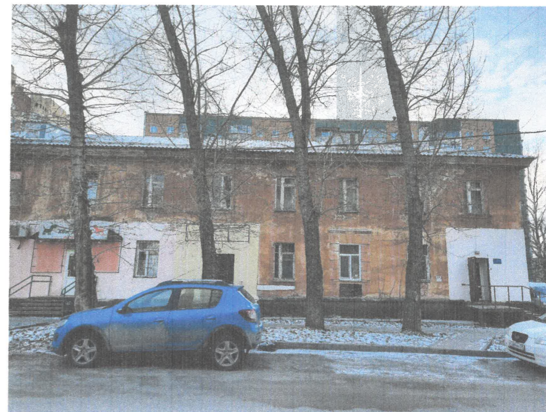
Существующее состояние главного фасада
