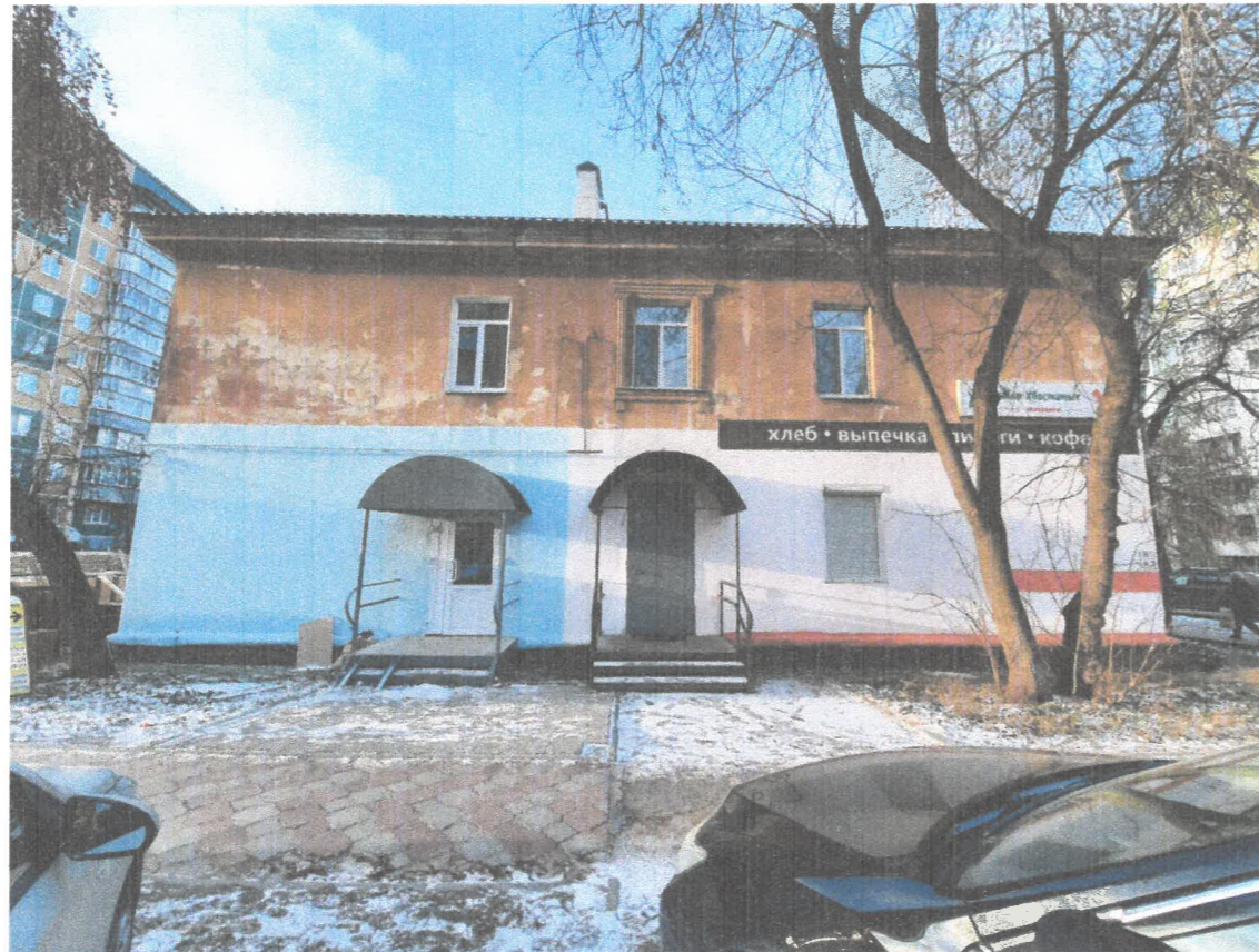
Существующее состояние фасада со стороны ул. Краснофлотской
