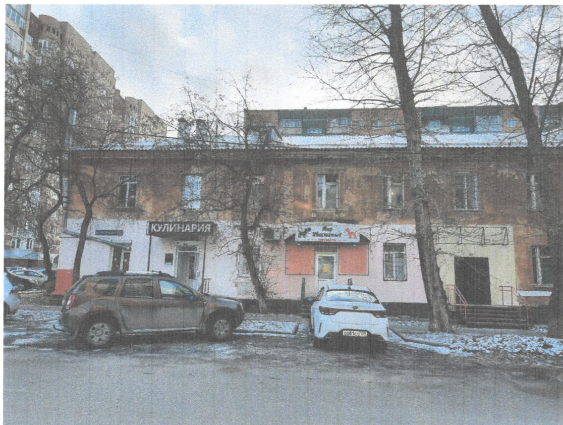
Существующее состояние главного фасада
