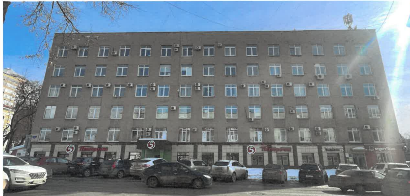
Главный фасад по ул. Екатерининской в осях 1-2
