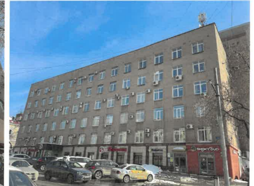
Главный фасад по ул. Екатерининской в осях 1-2
