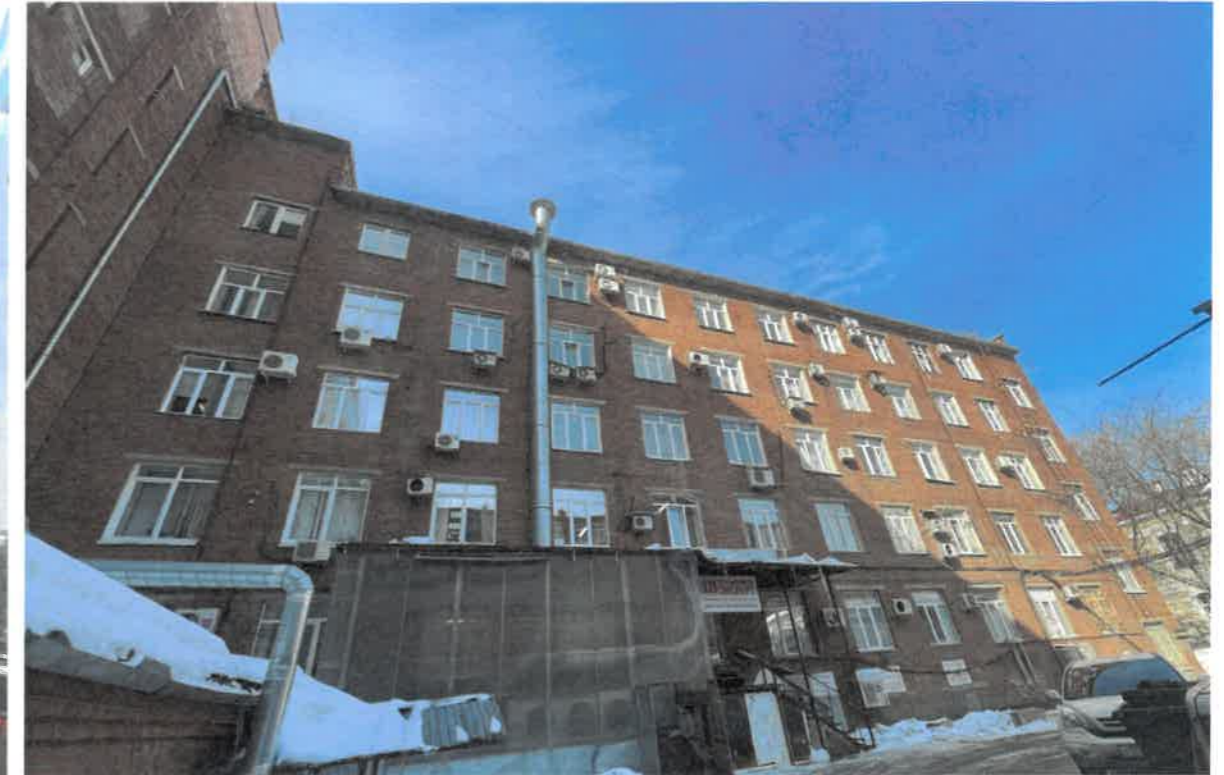
Дворовой фасад в осях 2-1
