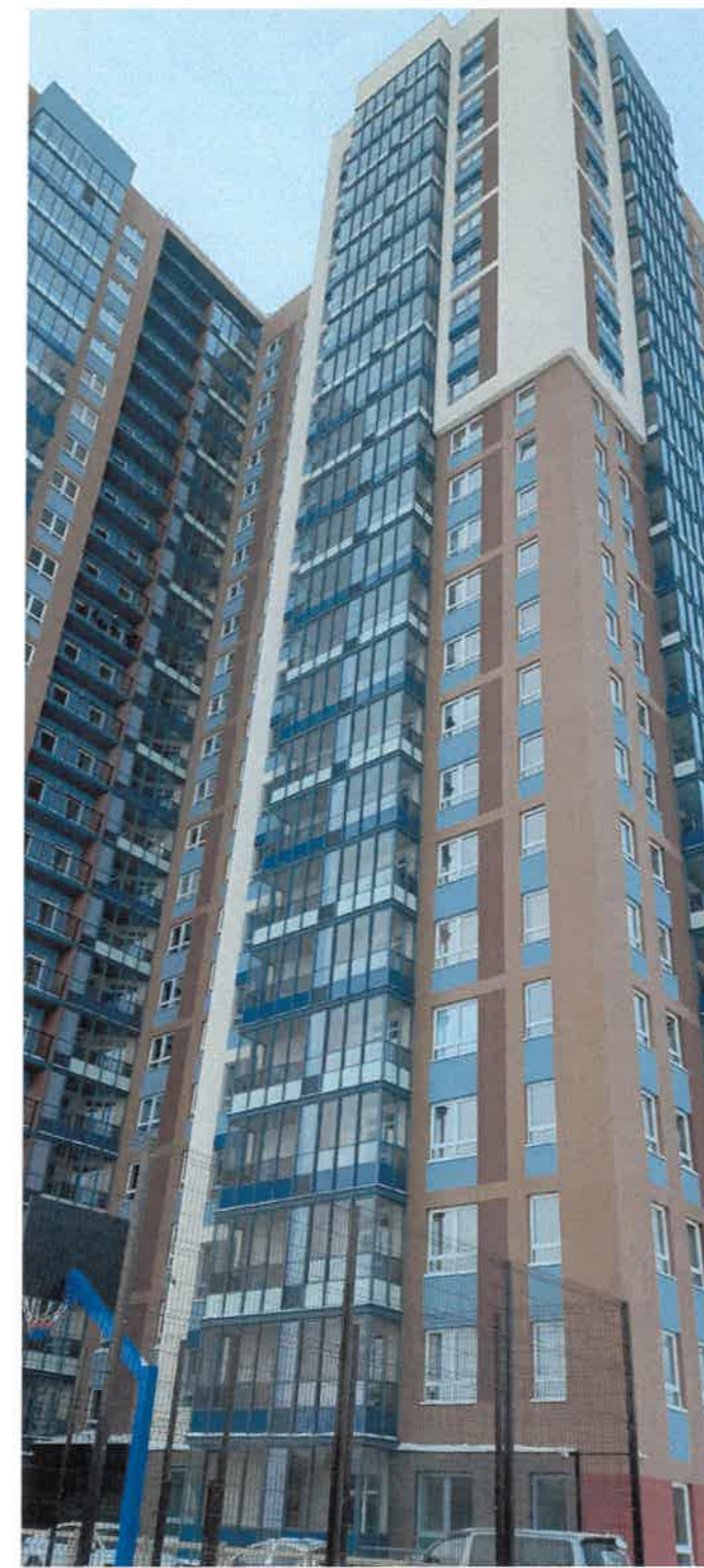
Дворовой фасад в осях В-Г (существующее положение)
