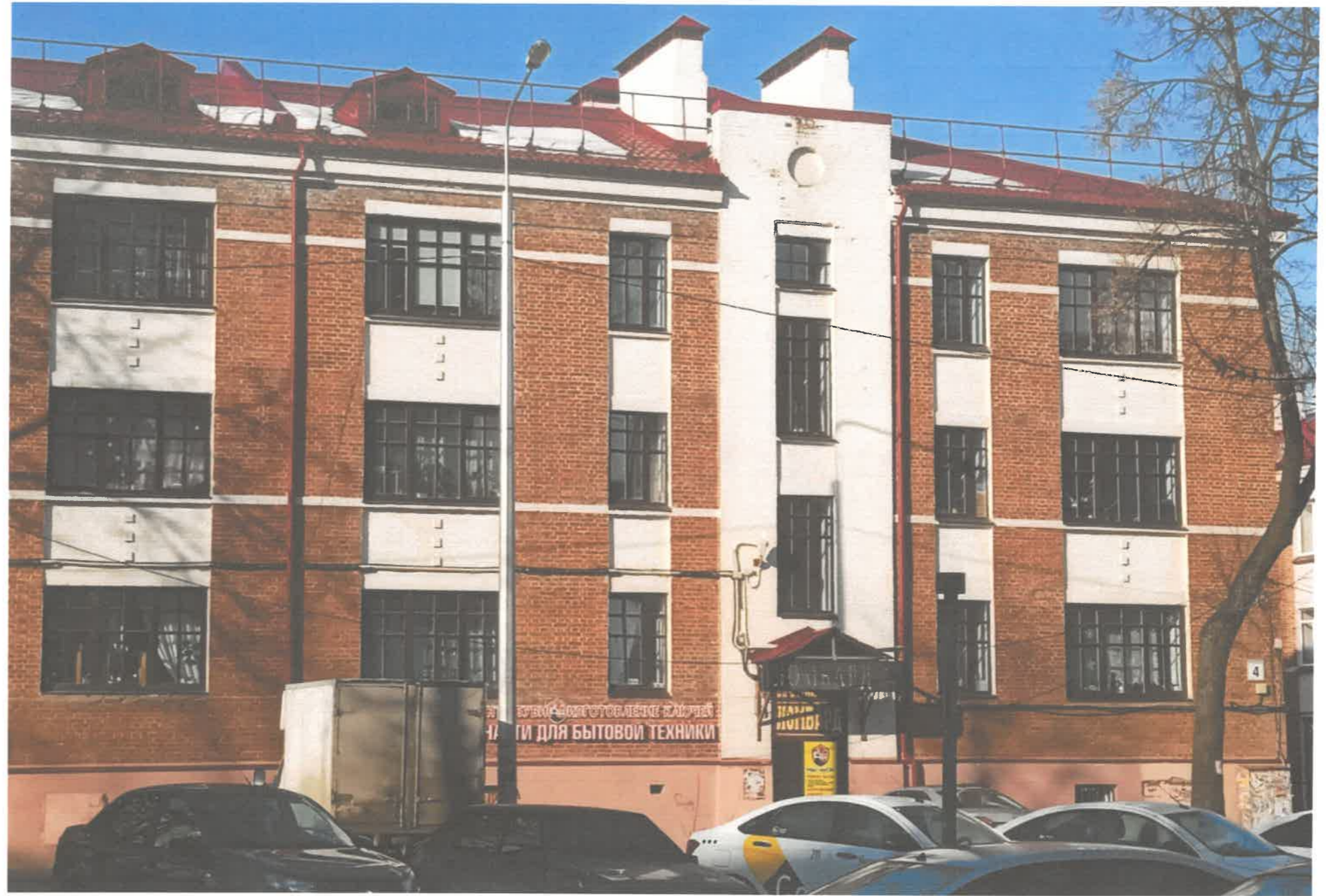
Фрагмент главного фасада
