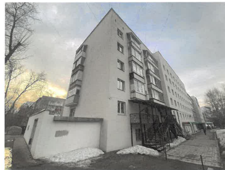
Боковой фасад и часть дворового фасада
