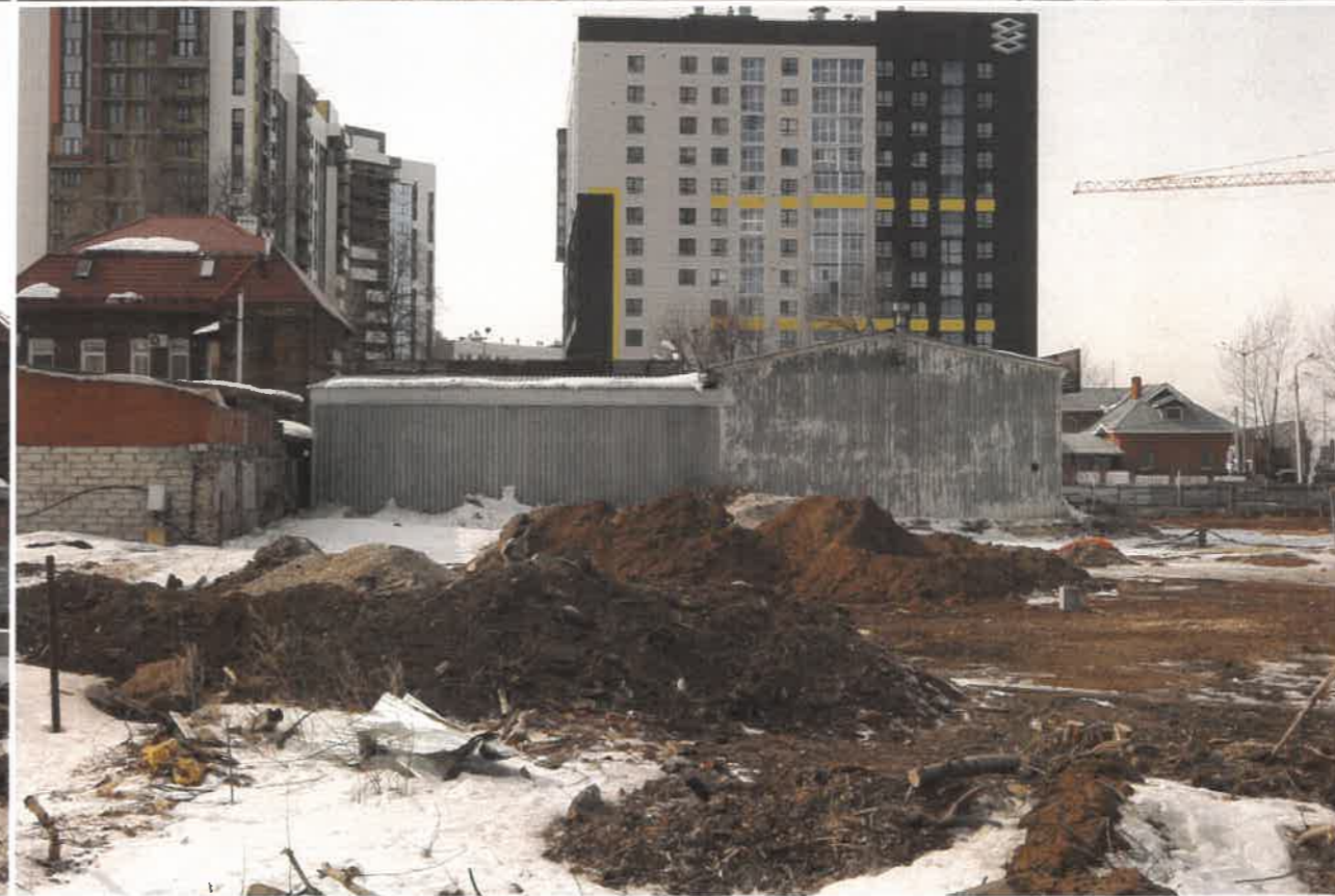
Дворовой фасад в осях 3-1
