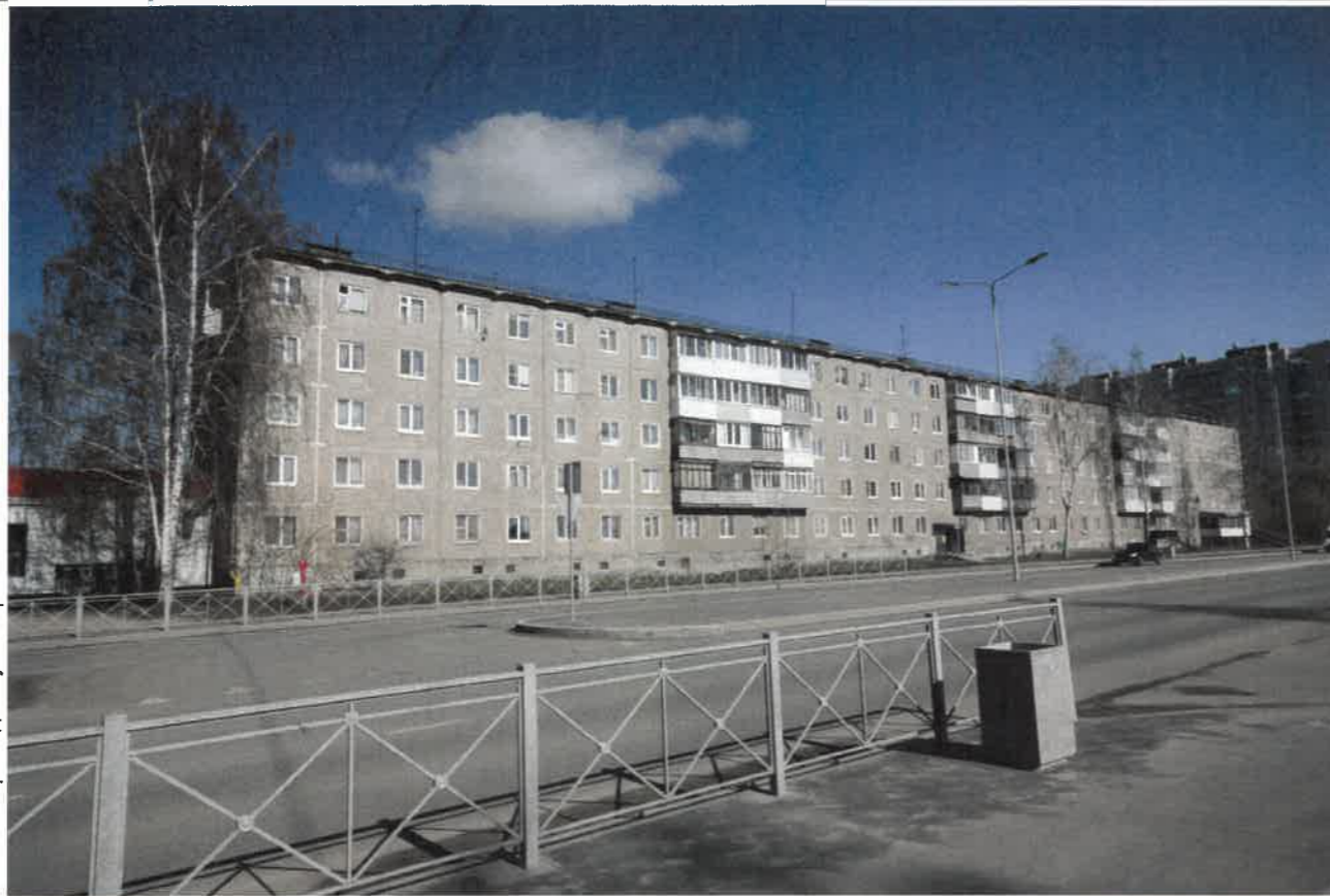
Главный фасад по ул. Карпинского
