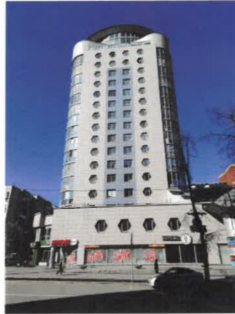
Главный фасад (ул. Г. Звезда)
