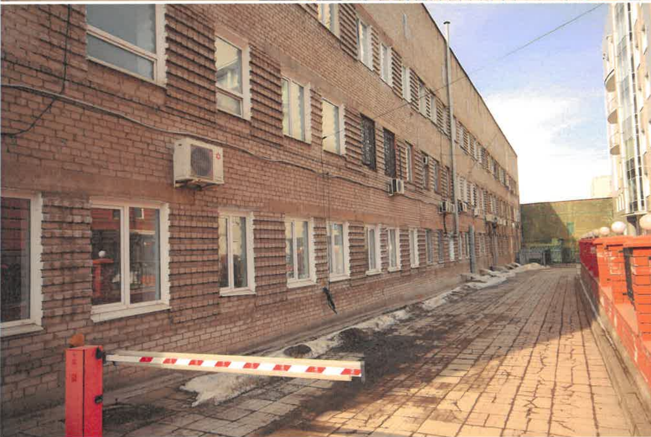
Фрагмент дворового фасада
