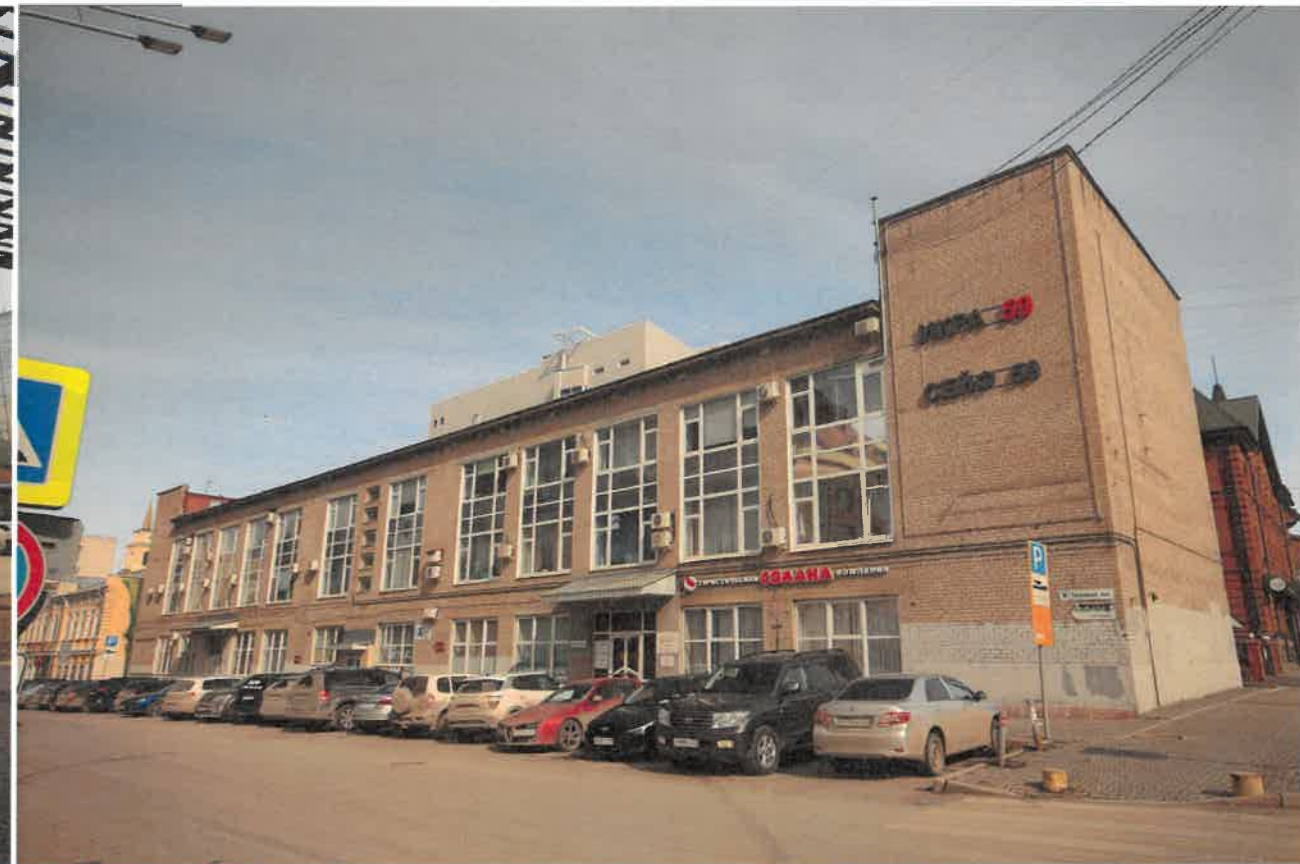
Главный фасад по Тополевому переулку и боковой фасад по ул. Петропавловской
