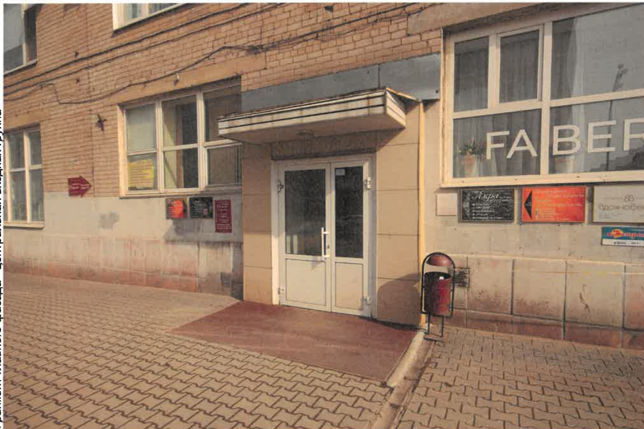
Фрагмент главного фасада - центральная входная группа
