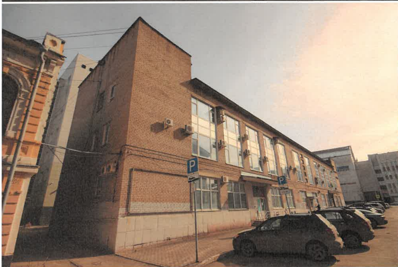
Главный фасад по Тополевому переулку и боковой фасад
