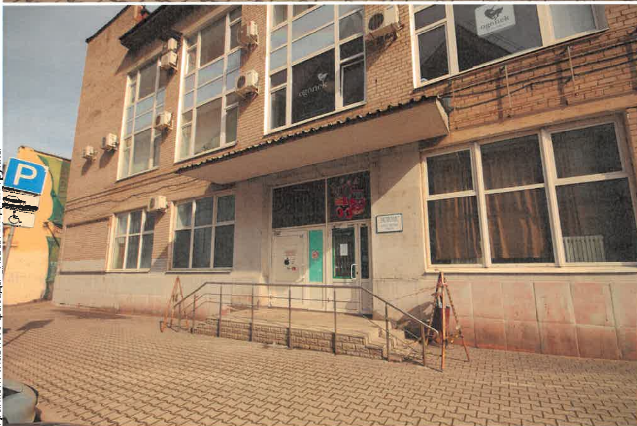
Фрагмент главного фасада - левая входная группа
