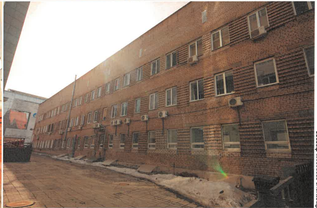
Фрагмент дворового фасада
