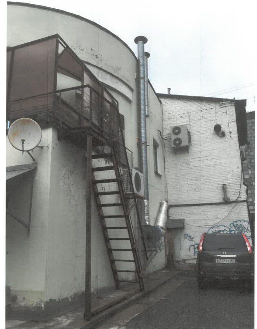
Существующее состояние дворового фасада (фотофиксация)
