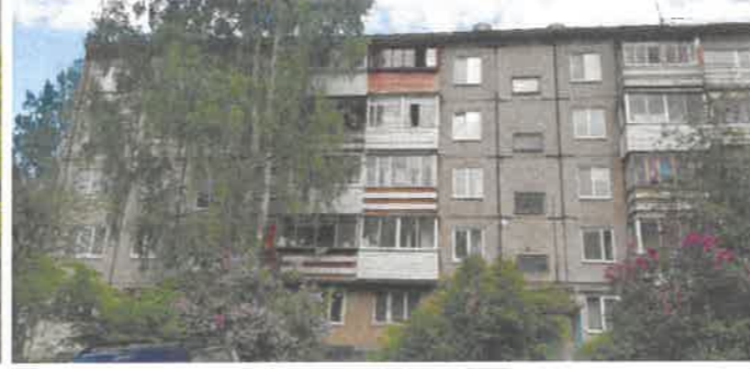
Дворовой фасад МКД
