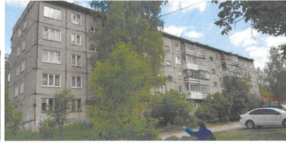
Дворовой фасад МКД
