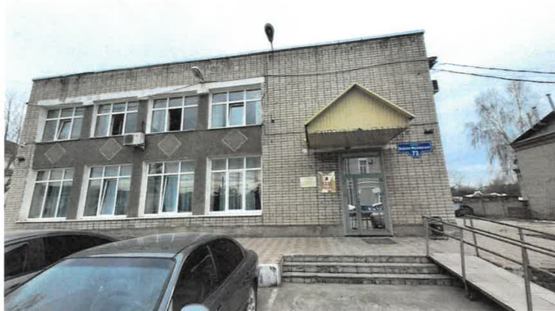
Главный фасад с улицы Верхне-муллинская
