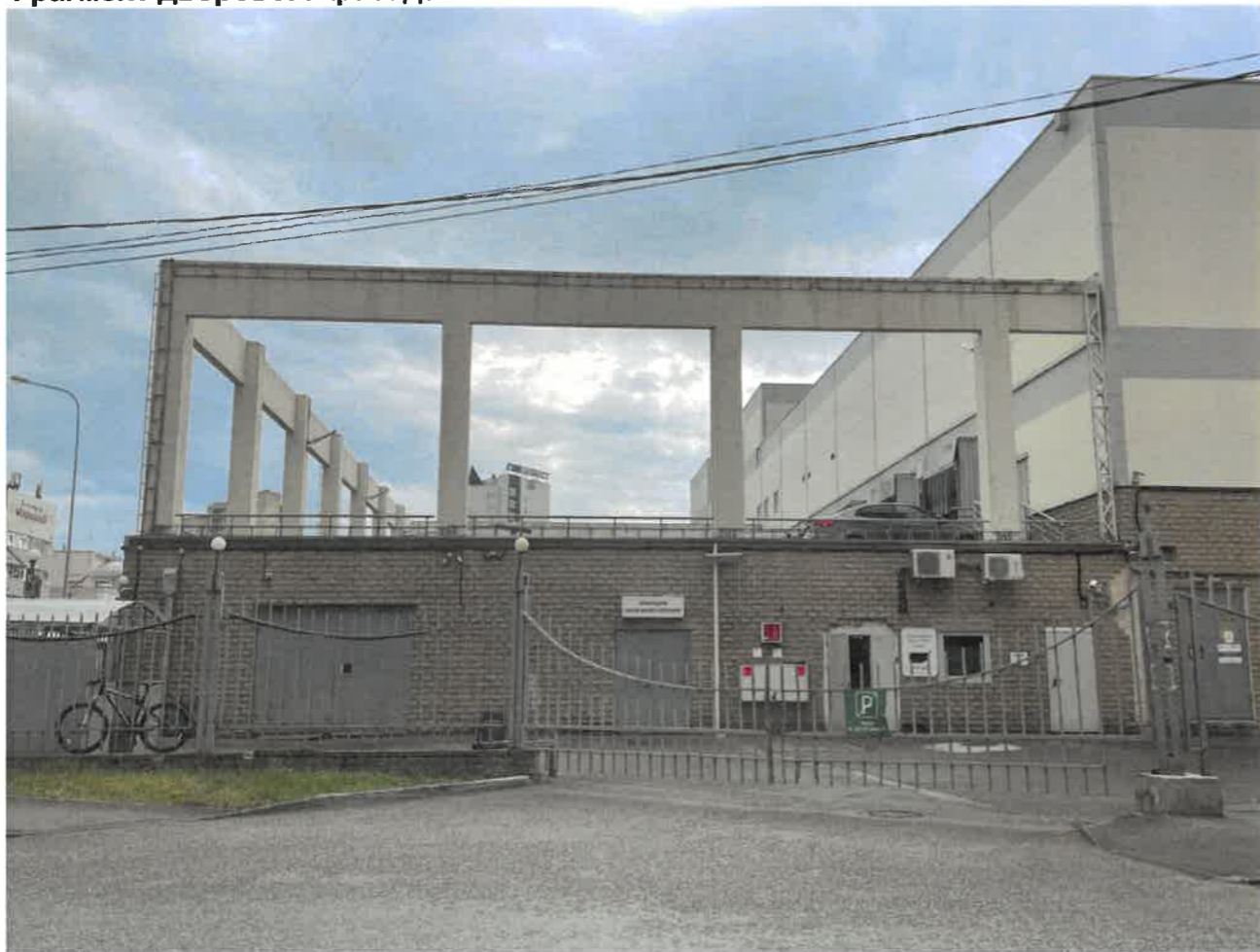
Фрагмент дворового фасада
