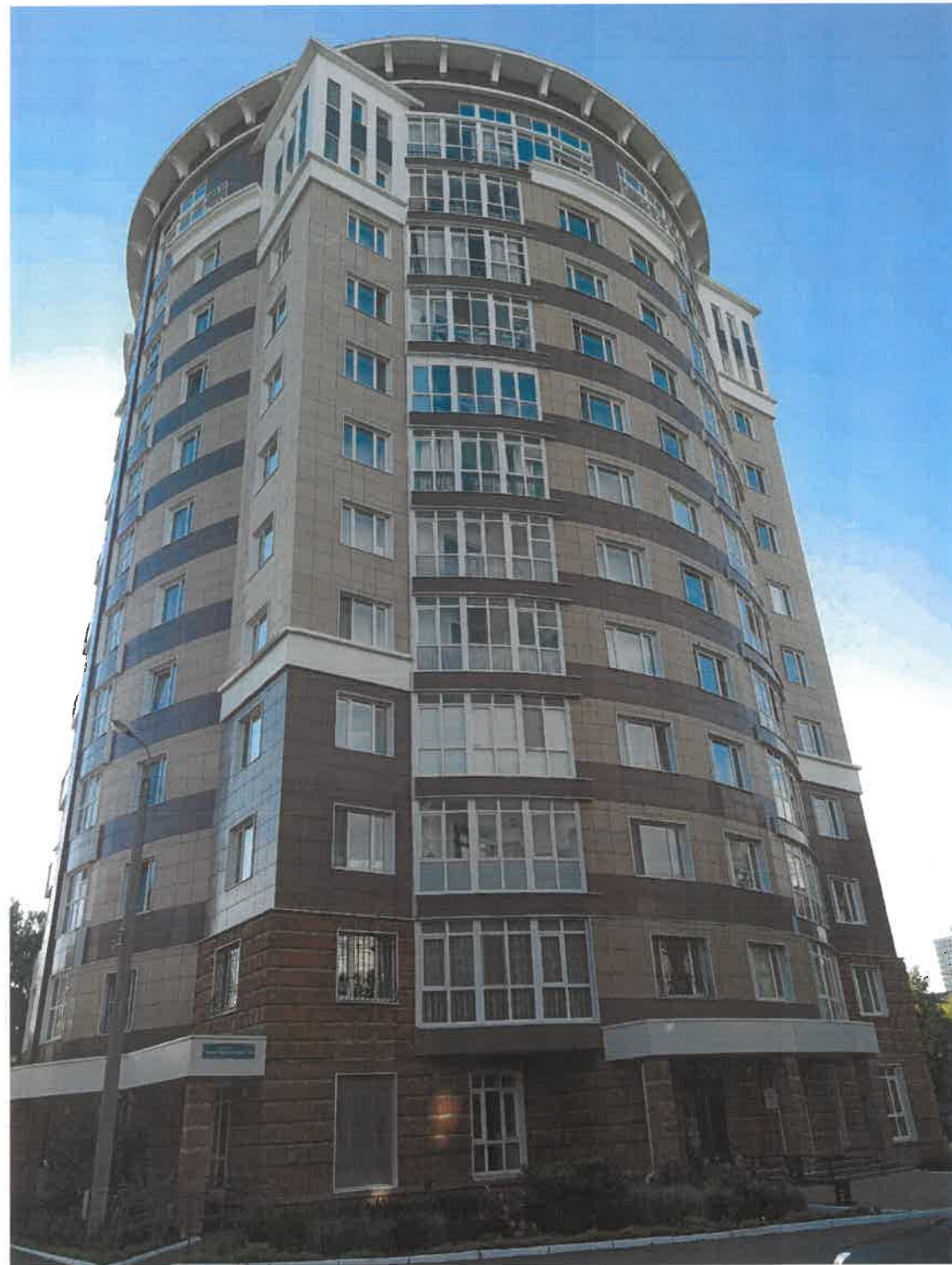
Существующее состояние фасада со стороны Комсомольского проспекта
