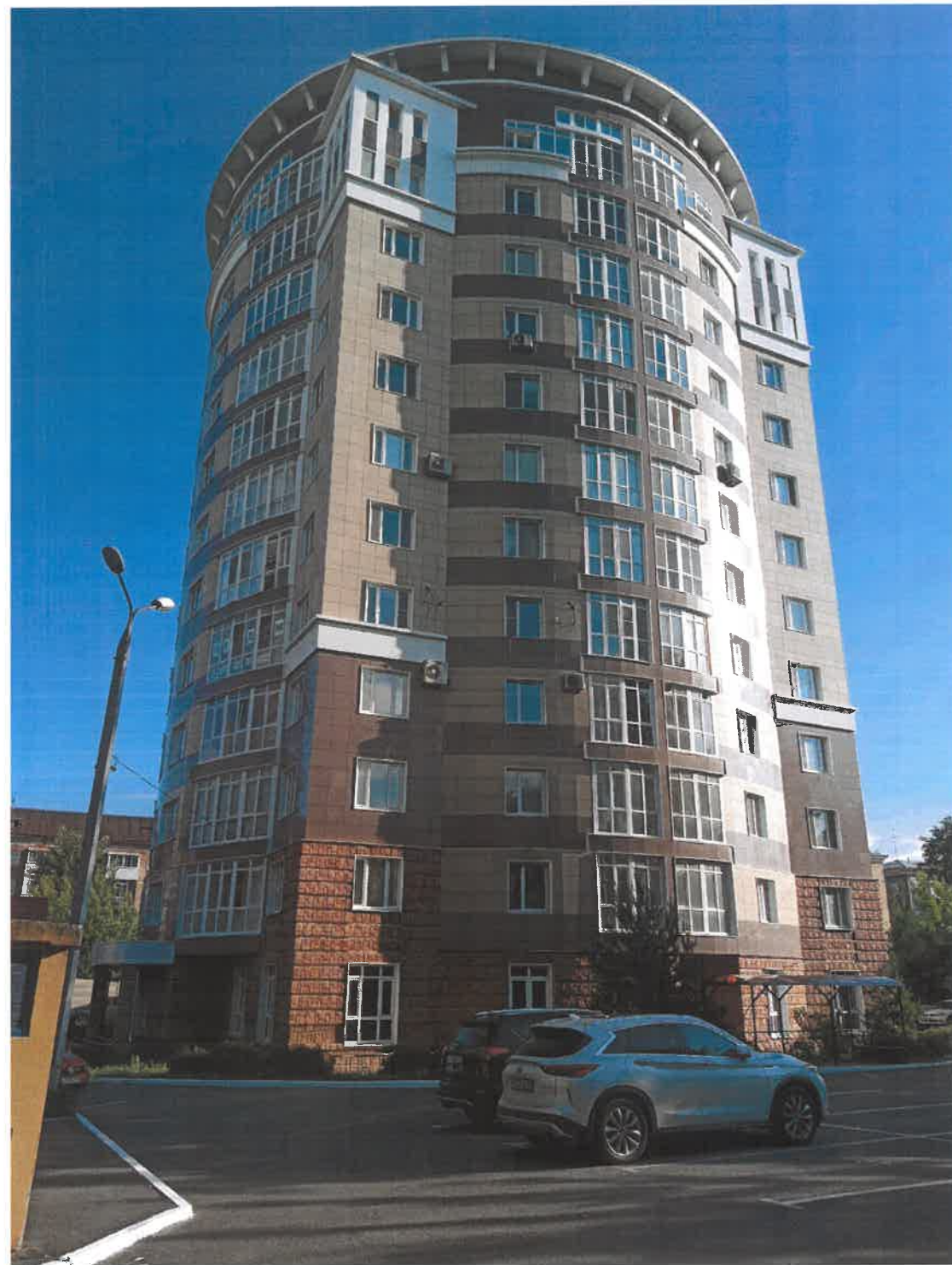
Существующее состояние фасада со стороны ул. П. Белинского
