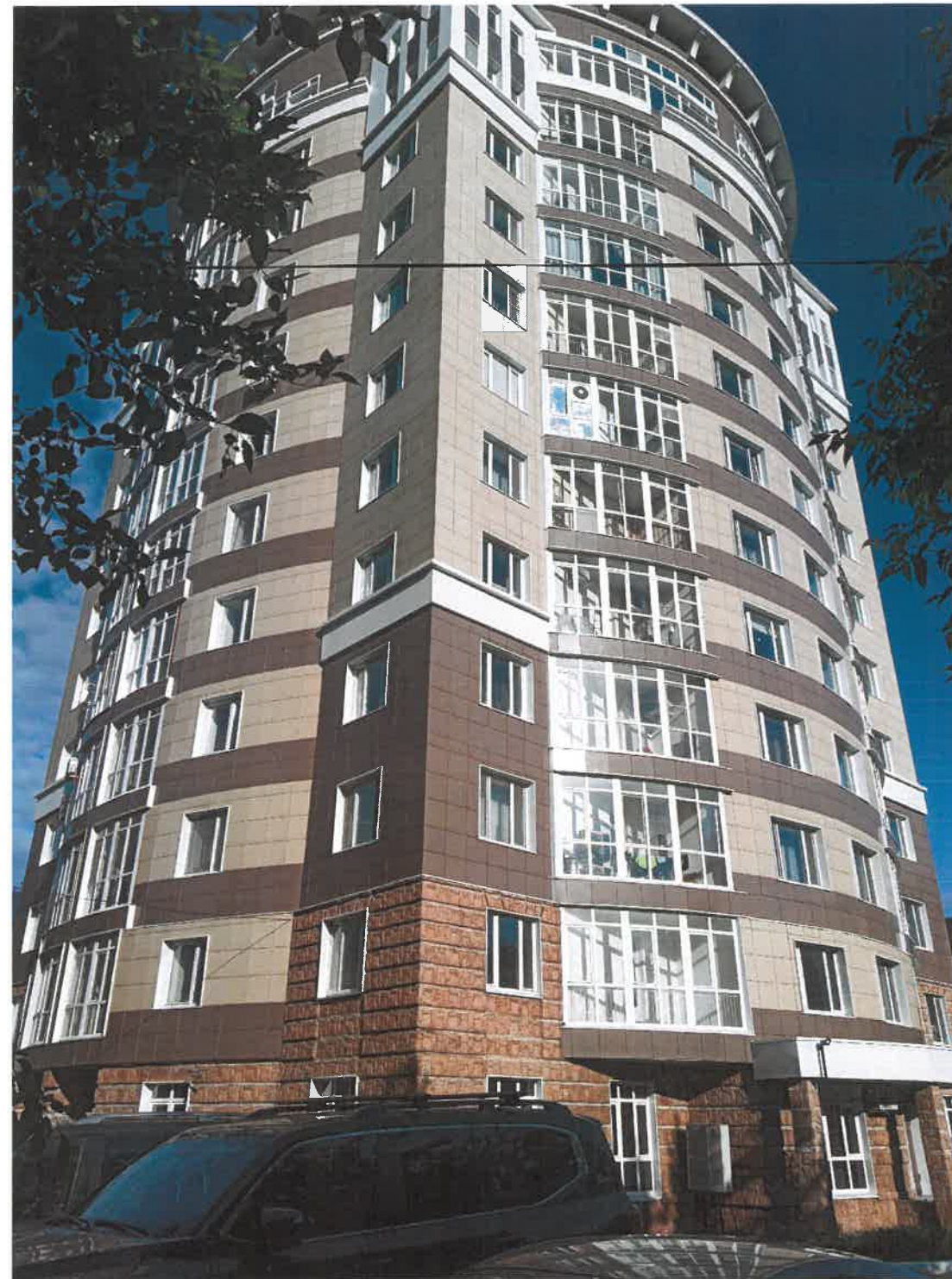
Существующее состояние дворового фасада
