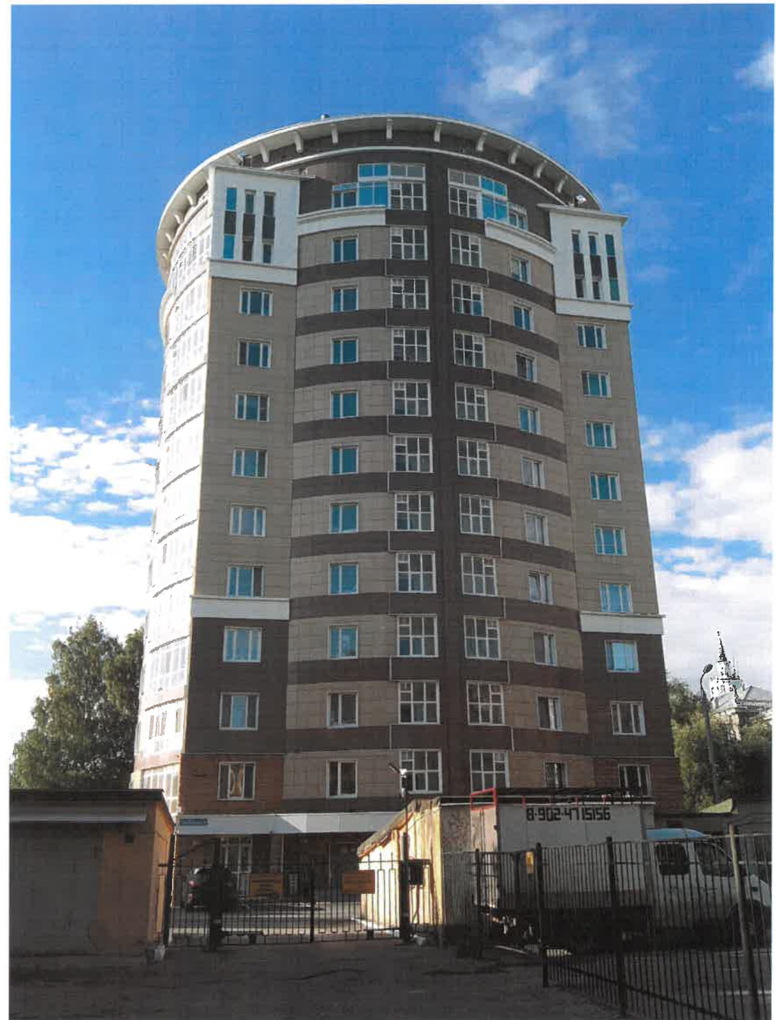
Существующее состояние фасада со стороны ул. П. Осипенко
