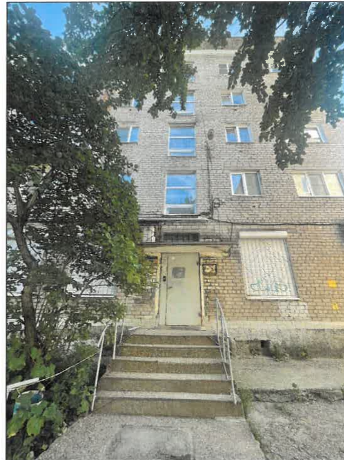
Фрагмент фасада в осях 2-1
