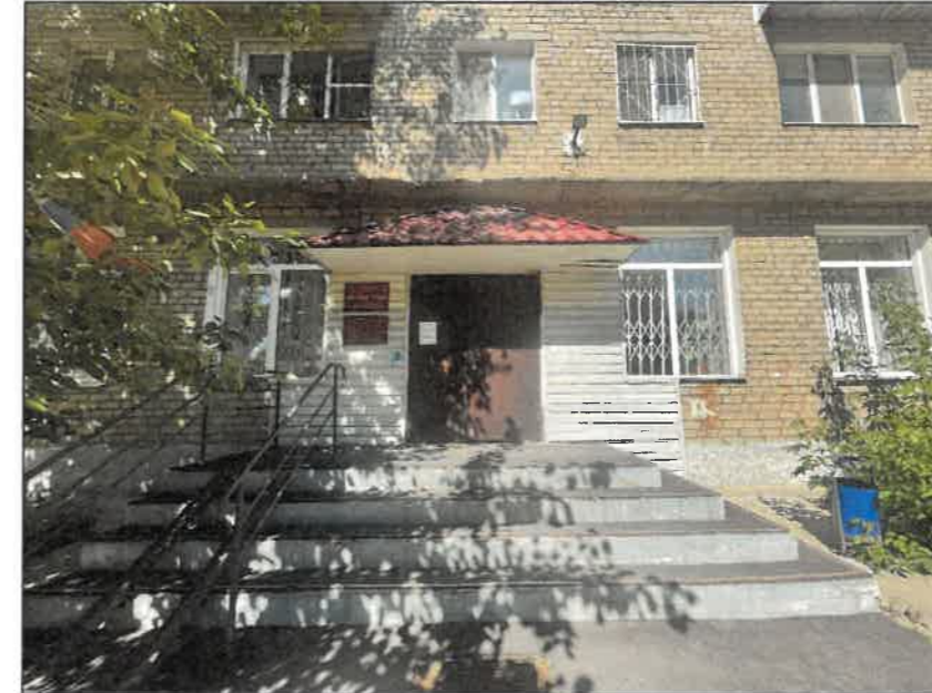
Фрагмент фасада в осях 1-2
