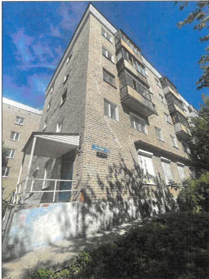
Фрагмент фасада в осях 1-2
