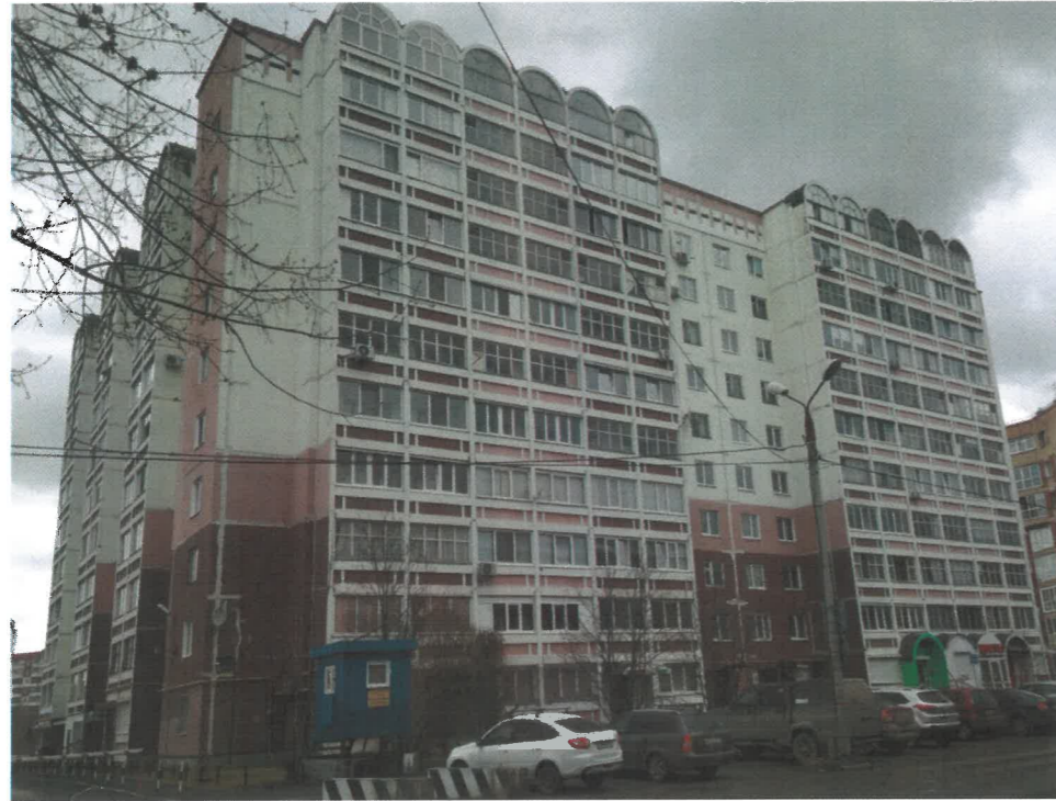
Существующее состояние фасадов в осях Д-А и 1-4
