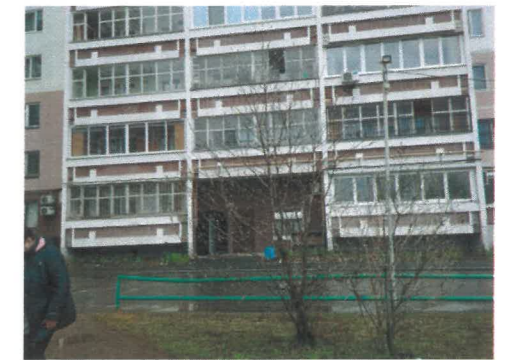
Существующее состояние дворового фасада в осях А-Д
