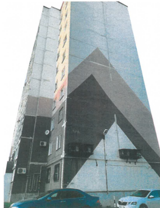
Существующее состояние бокового фасада в осях А-Б
