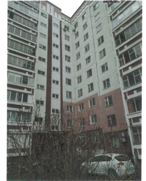
Существующее состояние дворового фасада в осях А-Д
