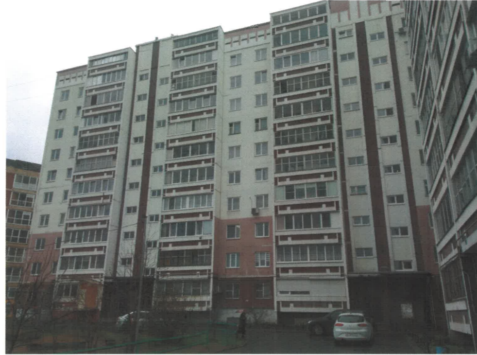
Существующее состояние дворового фасада в осях 4-1
