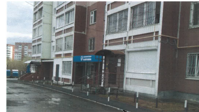
Существующее состояние фасада в осях Д-А
