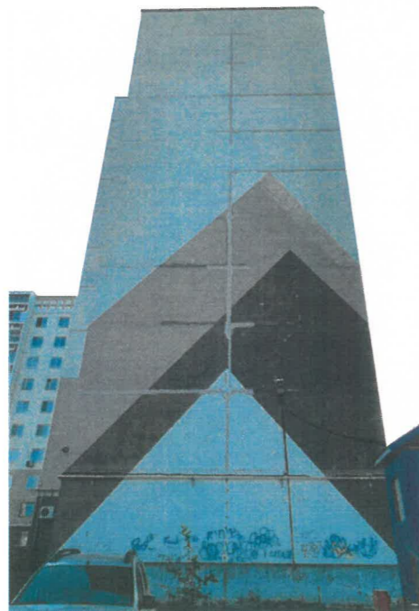
Существующее состояние бокового фасада в осях 2-1
