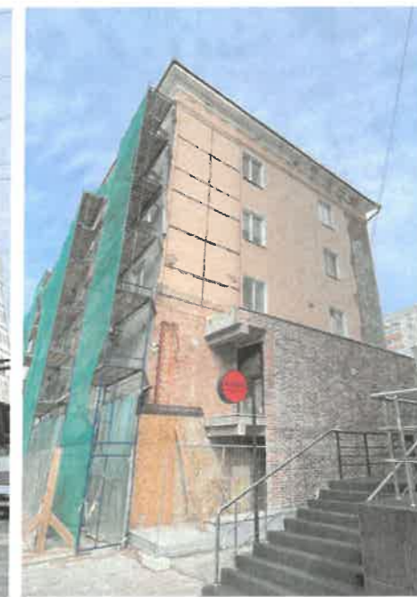
Существующее состояние бокового фасада (фотофиксация)
