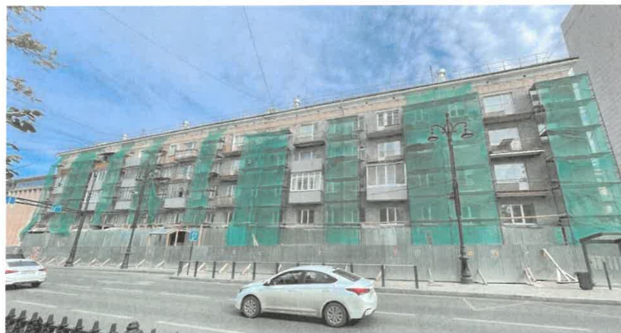
Существующее состояние главного фасада (фотофиксация)
