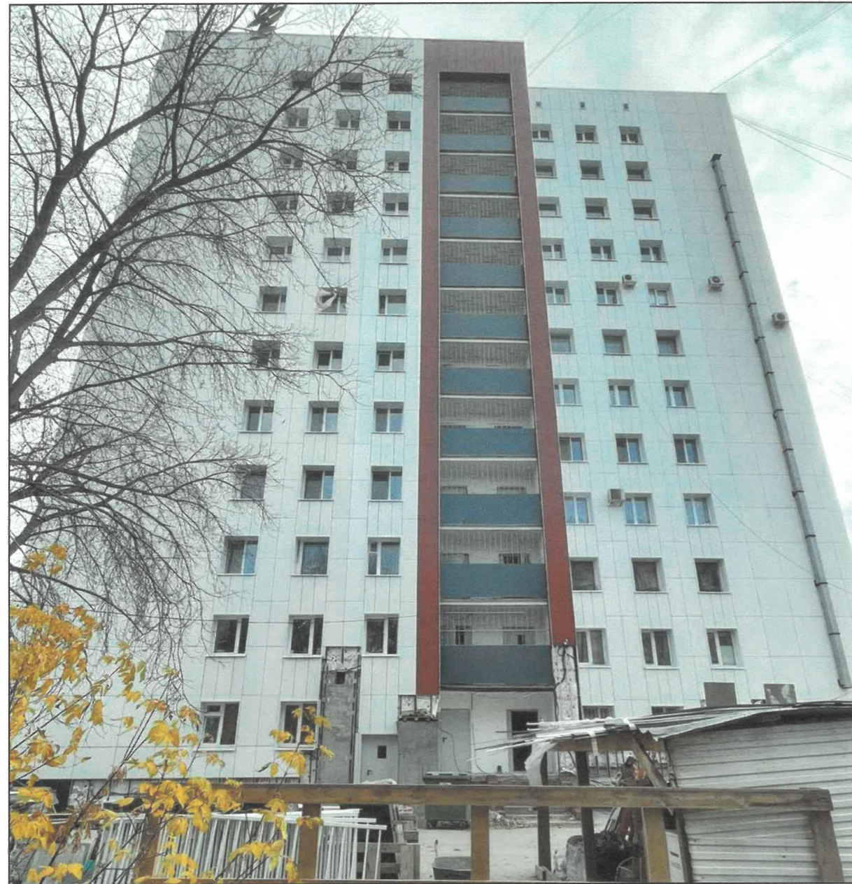
Дворовой фасад в осях 11-1
