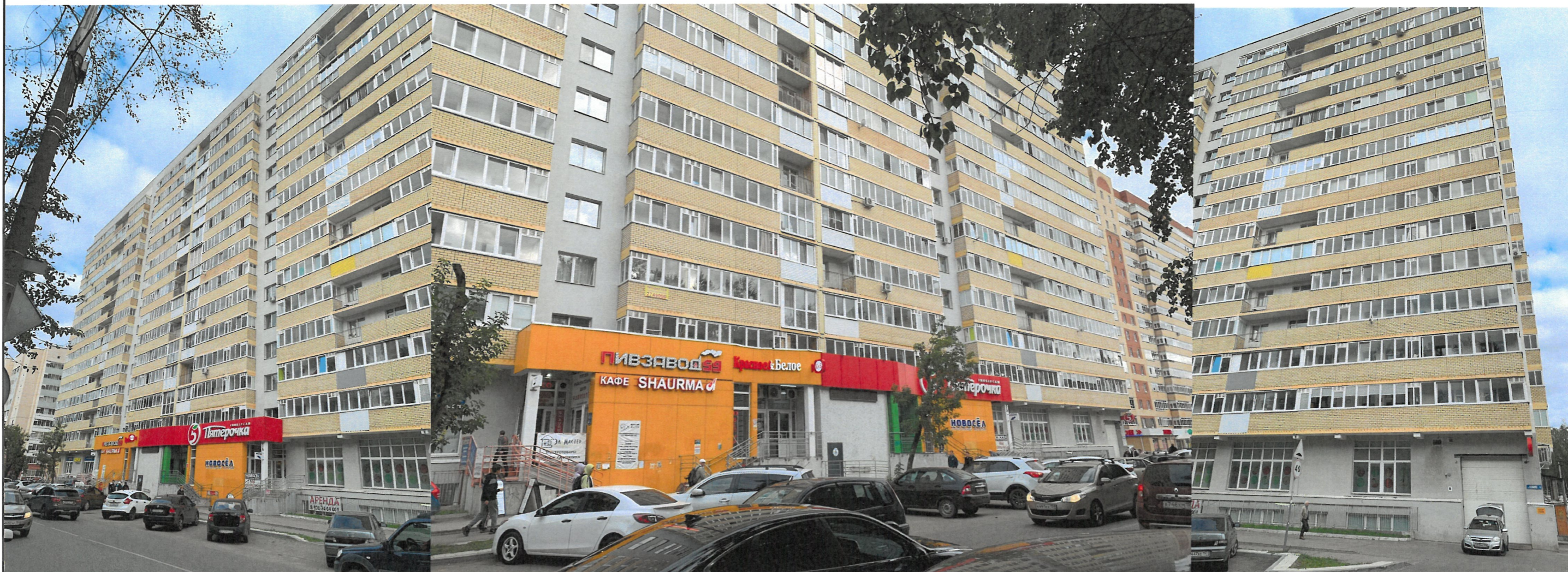
Существующее состояние главного фасада
