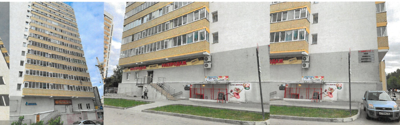
Существующее состояние боковых фасадов
