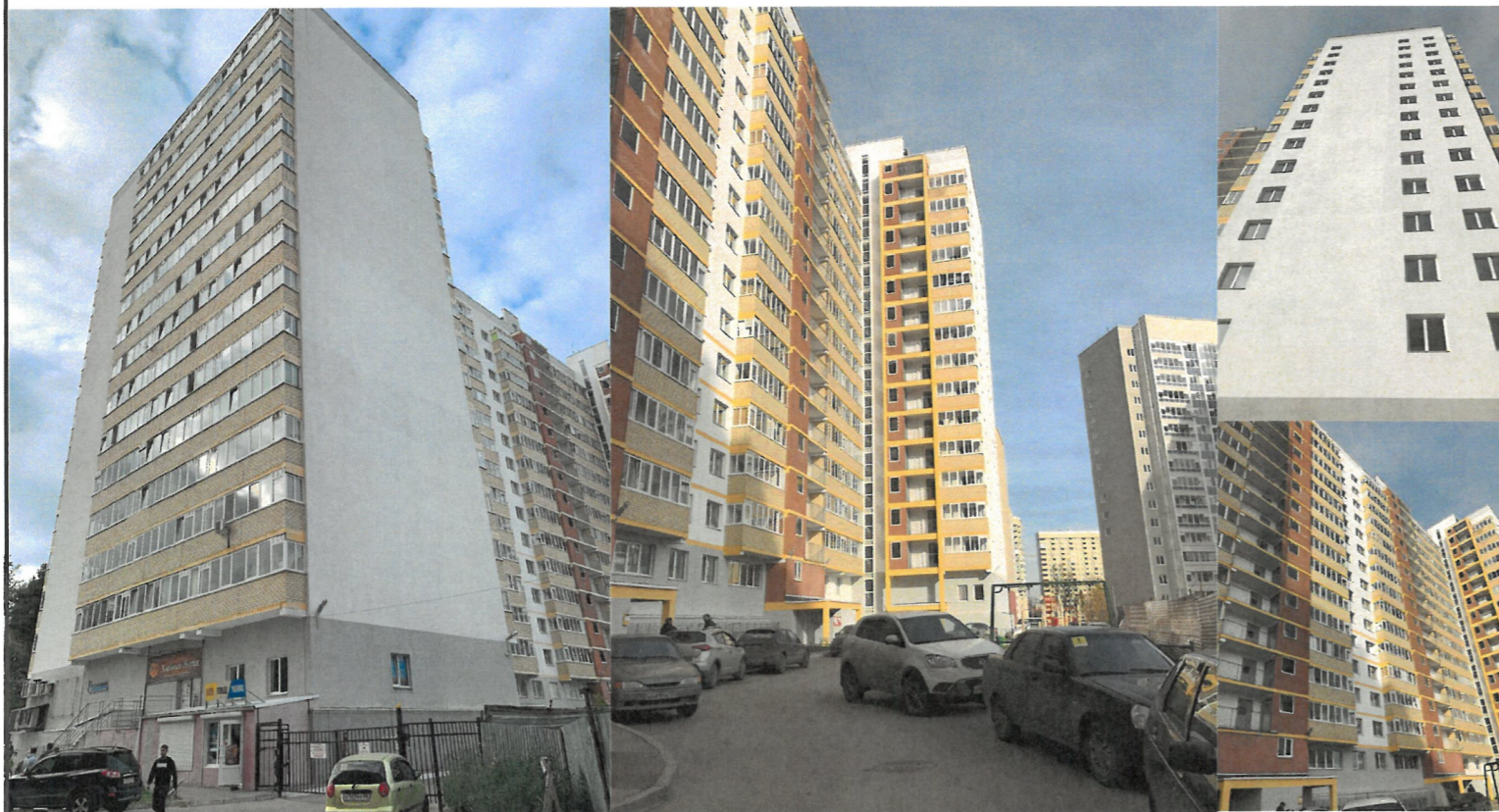
Существующее состояние дворового фасада
