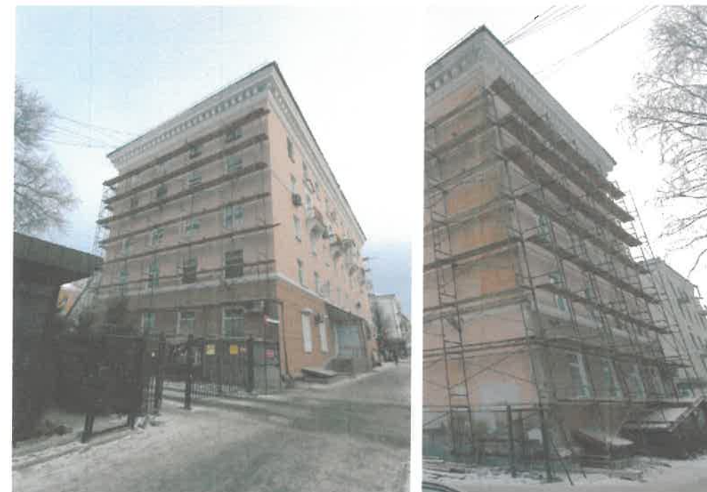
Существующее состояние бокового фасада (вид В)
