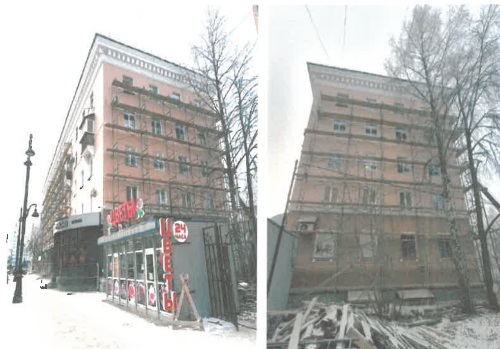
Существующее состояние бокового фасада (вид Д)
