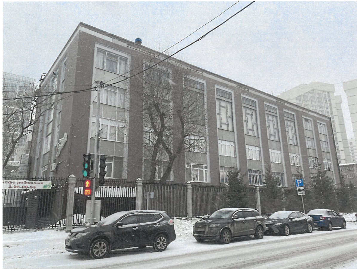
Боковой фасад (в осях 1-5)
