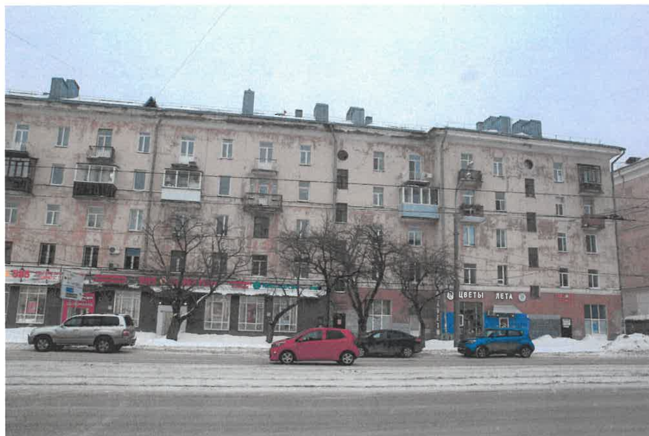
Фасад по ул. Крупской 25
