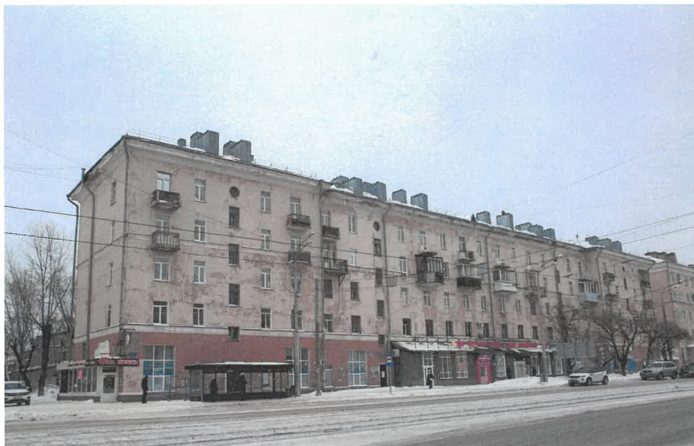
Фасад по ул. Крупской 25
